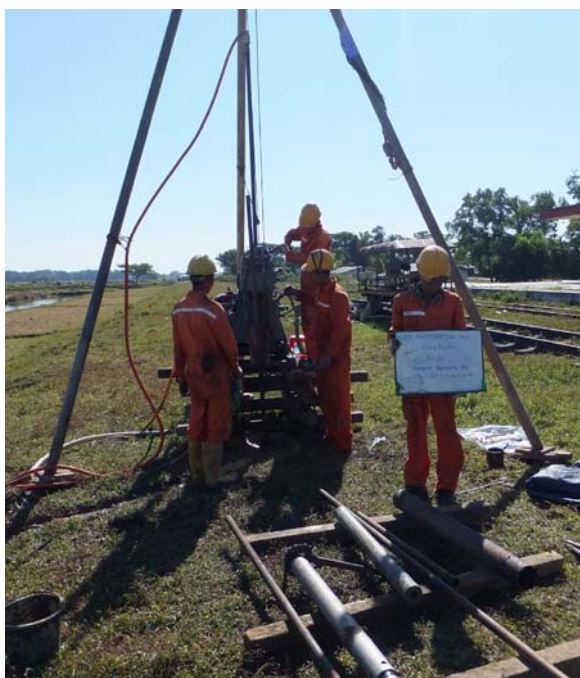
写真 3.4-1 ボーリング調査状況
