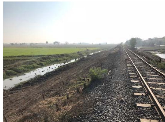
D-Box Dam 斜面転圧完了
