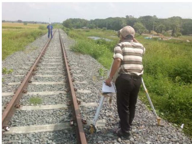
図 7.1-1 観測状況写真：線路の左側を 20m 間隔で計測（CH220～CH580：19 箇所）
