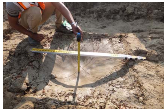
写真 2.7-1(2) 試験後の原地盤状況 (D-Box 下部)
