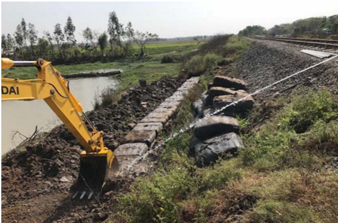
写真-3 斜面すべり対策（D-Box Dam 工法による）
