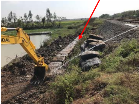
D-Box 設置後の散水と転圧
