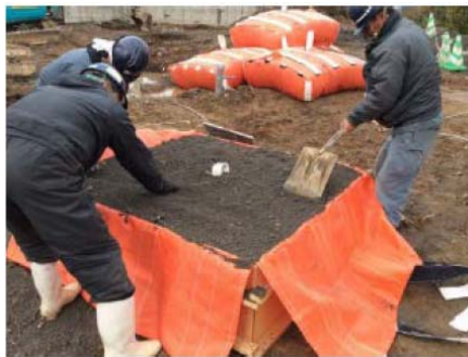
図 2-2-1 D-Box への中詰め作業 (砂)
