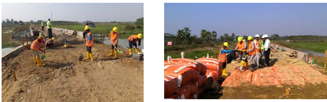
図 4.4-6 乾季による路床の掘削と D-Box の設置及びランマーによる転圧状況
