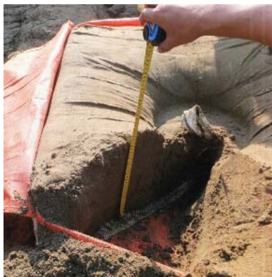
写真 2.7-1(1) 平板載荷試験後の断面状況
