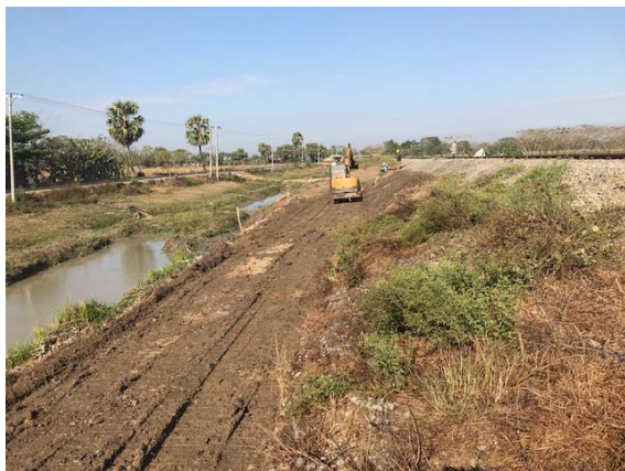
D-Box Dam 設置後のバックホウによる転圧
