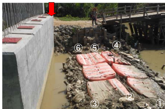
図 4.2-7 軟弱地盤上の仮設足場としての利用例 (支持力増大)
