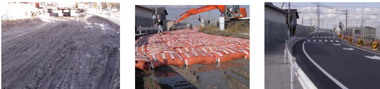
図 4.2-4 道路下路盤使用例（日本 滋賀県）
