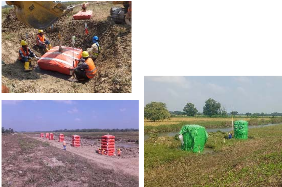
写真-5 圧密沈下計測 (地盤が良質であり1年間の計測結果ではD-Boxによる圧密抑制効果は検証できなかった)
