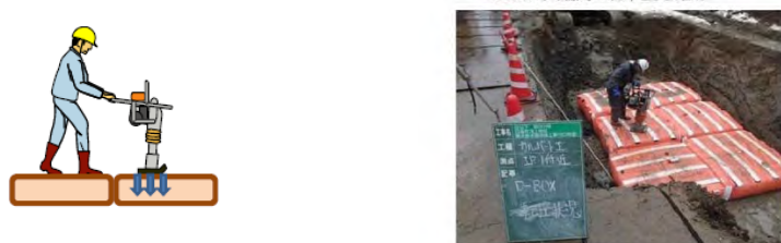
図 4.4-5 ランマーによる加圧
