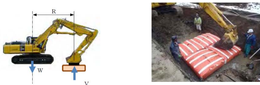
図 4.4-4 バックホウによる強制加圧
