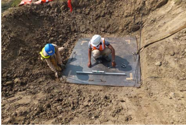
写真 7.2-1 載荷試験設置箇所整地状況
