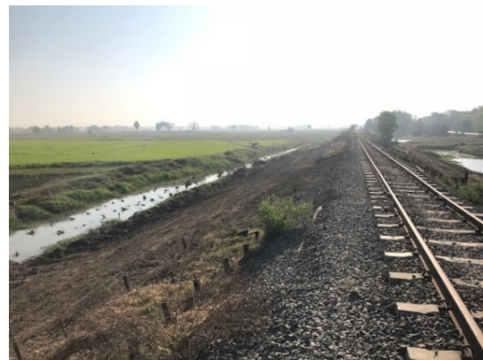
D-Box Dam 斜面転圧完了
