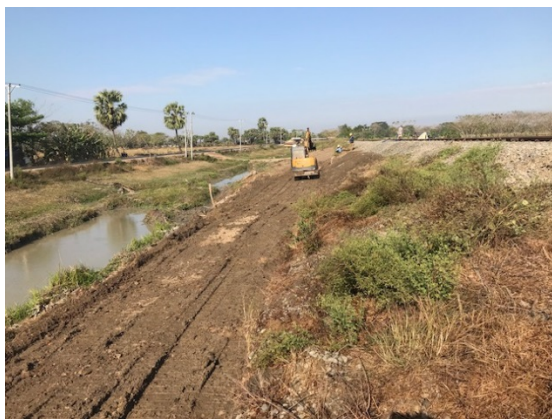
D-Box Dam 設置後の backhoe による転圧
