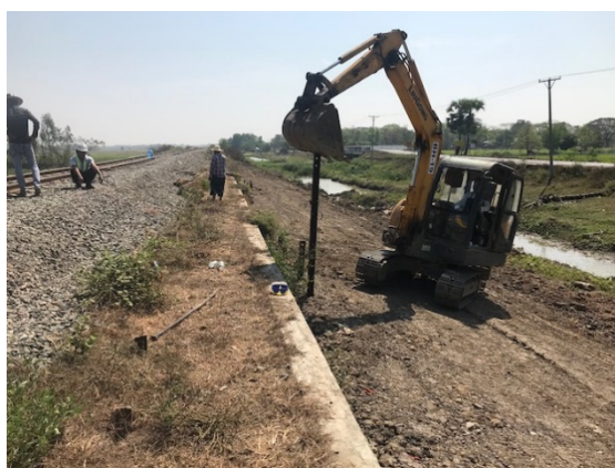
図 5-4 rail piles を用いた斜面補強
