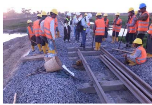
2017年2月 CH520 付近枕木設置
