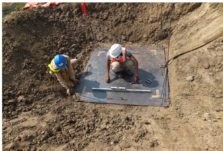
図 3-88 載荷試験設置箇所整地状況
