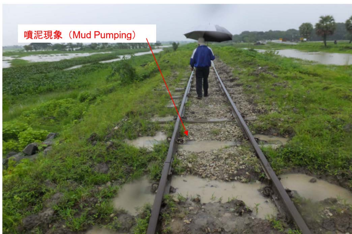
図 3-53 エインメの Chaungphyar Site の雨季の状況 (施工前)
