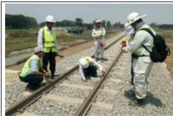
2017年4月 完了検査 (5m 間隔高さ計測)
