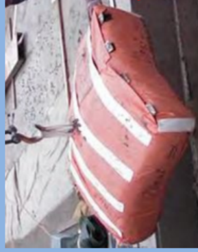
内部拘束式箱型土のう D-Box
