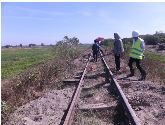
図 3-29 現場確認時の補修状況 CH500 付近
