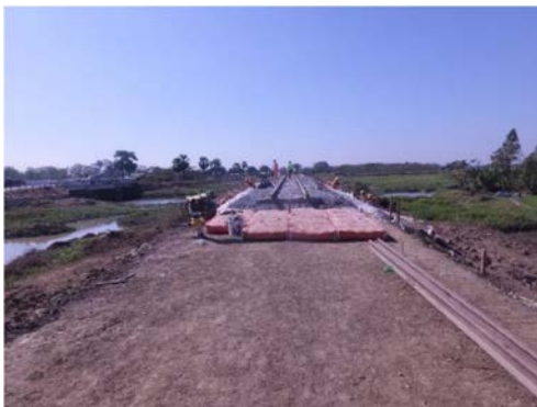
2017年2月 CH550 D・Box 基礎設置
