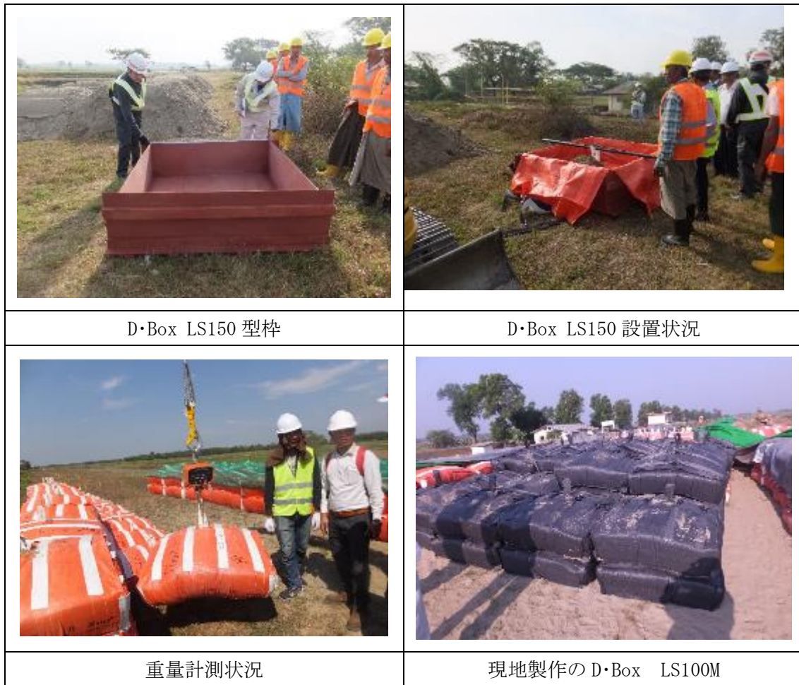
図 3-33 D・Box 製作状況
