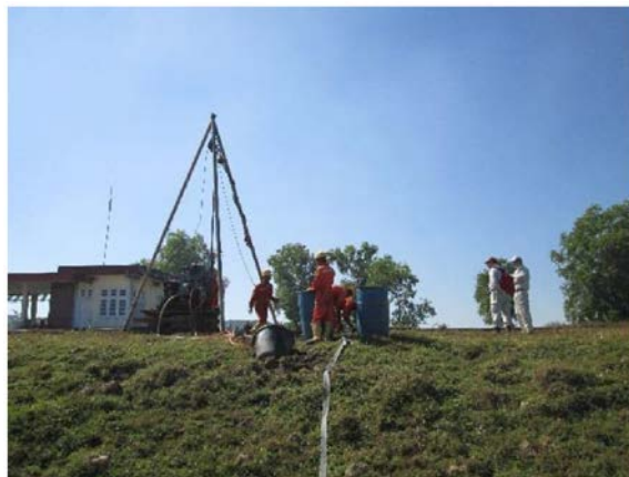
図 3-7 ボーリング調査状況
