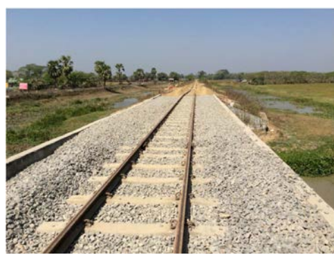
2017年2月 CH460 軌道完成状況
