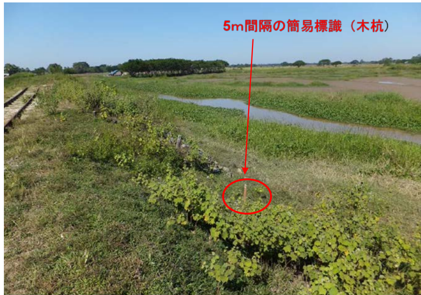
図 3-1 5m 間隔の簡易標識
