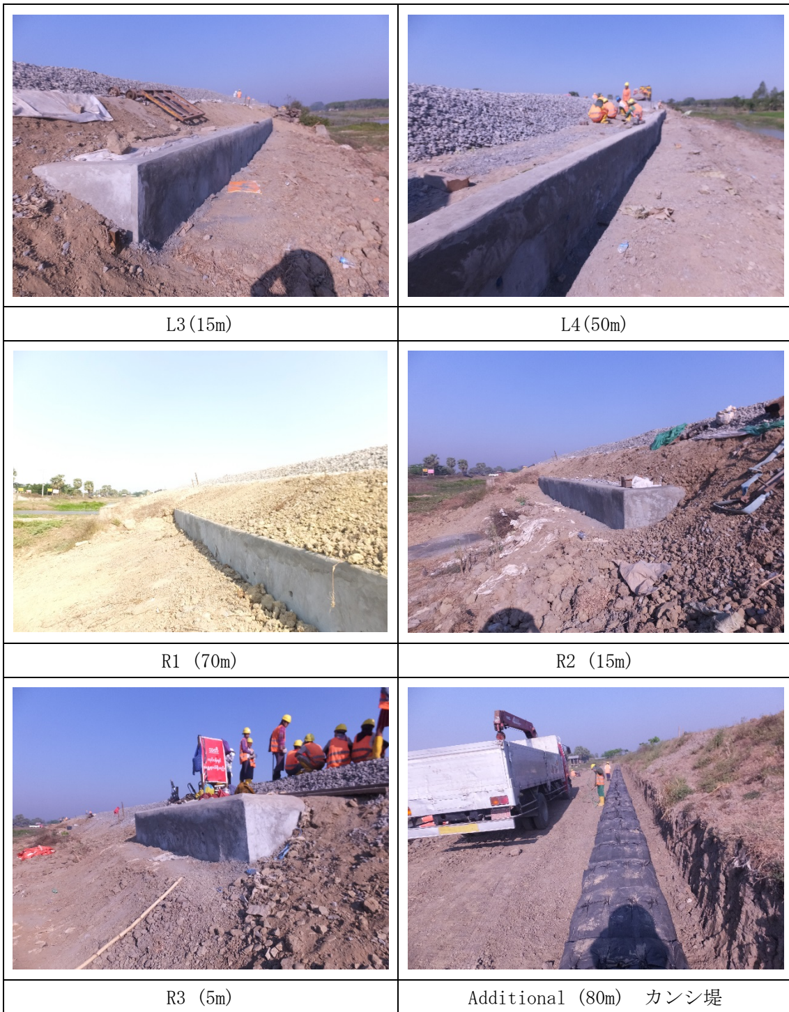
図 3-38 擁壁の施工状況
