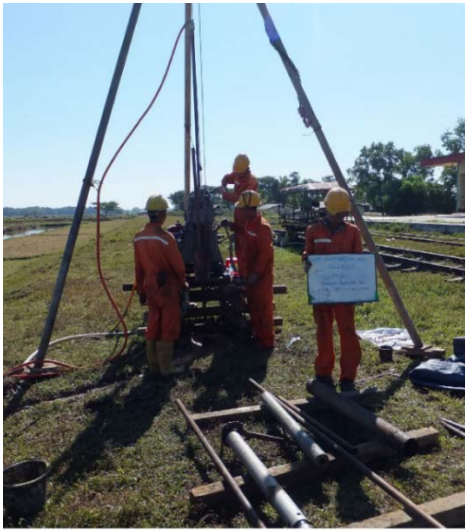
図 3-67 ボーリング調査状況
