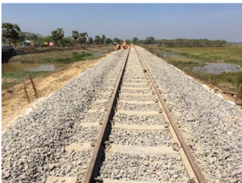
2017年2月 CH580 軌道完成状況
