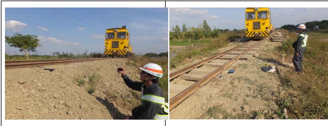
図 3-51 D・Box 改良前の振動計測実施状況写真 (2017 年 2 月 15 日)
