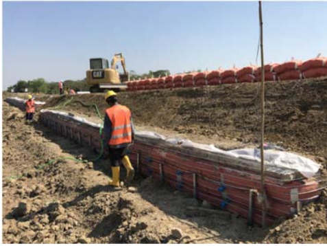
2017年2月 D・Box 擁壁3段設置 CH500
