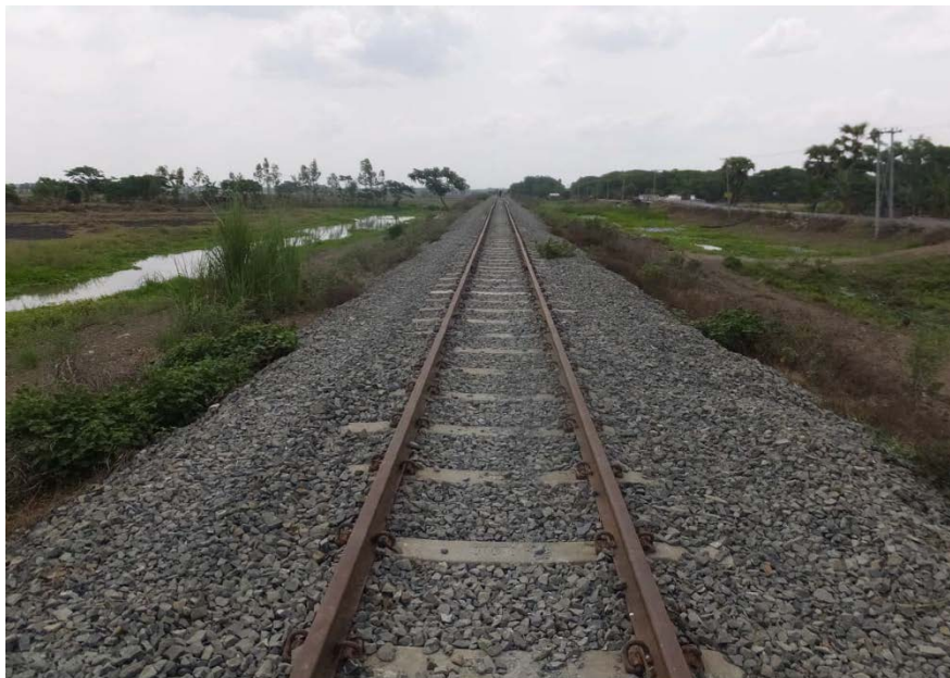
図 3-62 D・Box 敷設 1 年後 乾季 2018 年 5 月初旬 出典：調査団撮影
