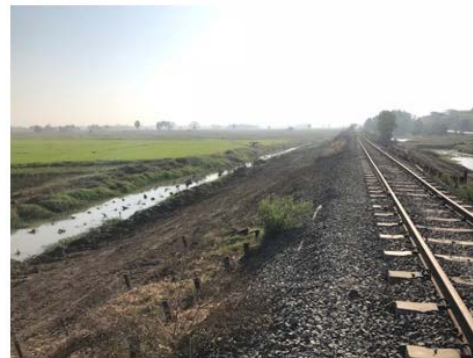
D・Box Dam 斜面転圧完了
