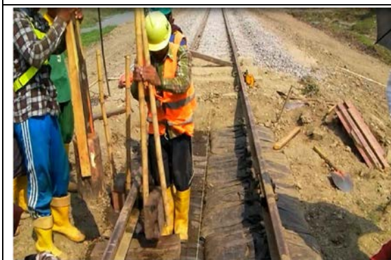
2017年4月 CH213 人力施工状況
