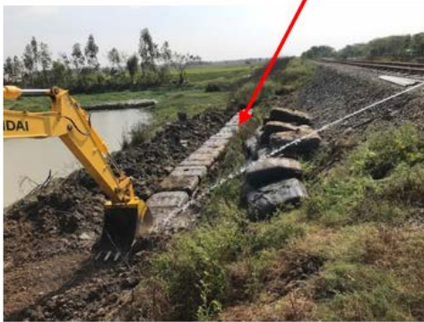
D・Box 設置後の散水と転圧
