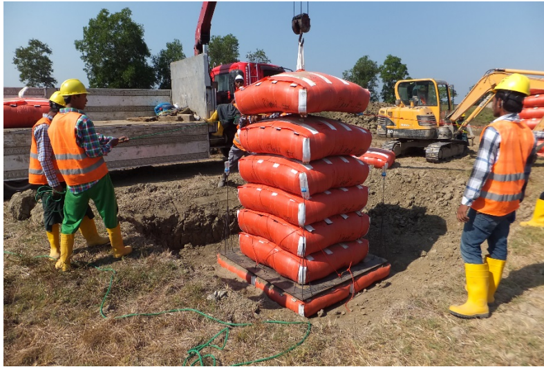
図 3-89 載荷試験設置状況
