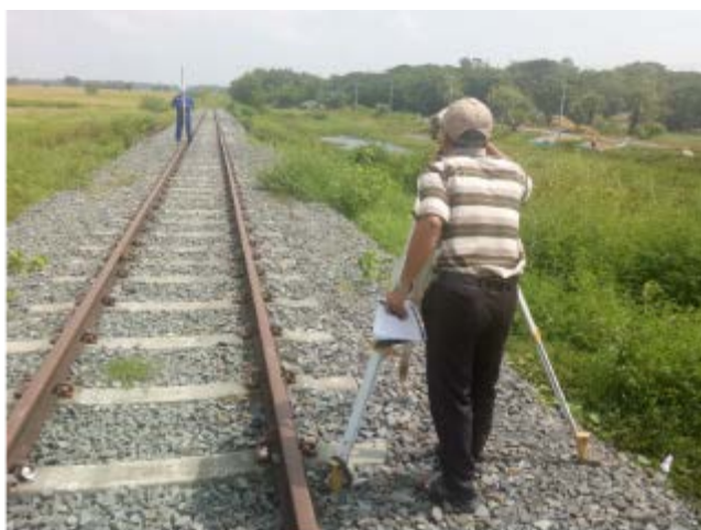
図 3-91 観測状況写真：線路の左側を 20m 間隔で計測 (CH220～CH580：19 箇所)
