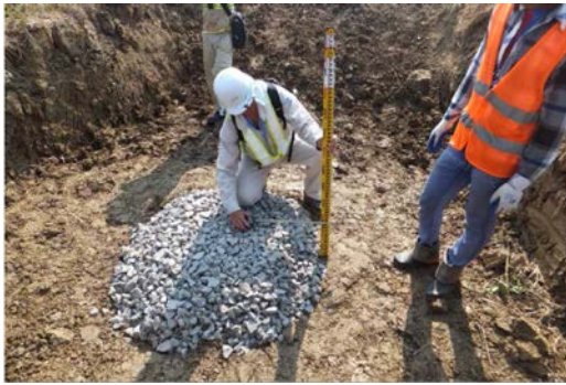
2017年2月 平板載荷試験：バラスト設置
