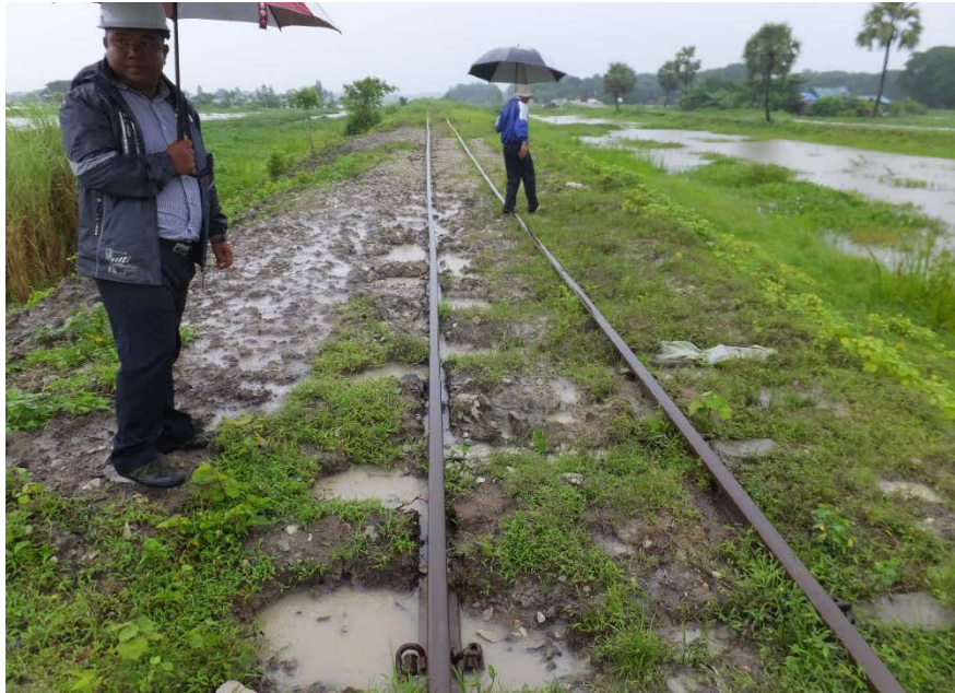
図 3-59 D・Box 敷設前 (CH220 付近) 2016 年 8 月中旬 出典：調査団撮影
