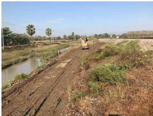
D・Box Dam 設置後のバックホーによる転圧
