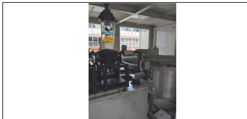
沈殿槽の様子
