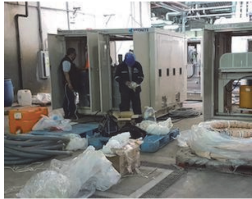
アマゾナステキスタイル社における 機材設置の様子
