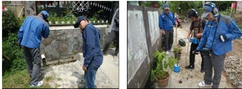
図 2-11 音聴棒や漏水探知器による漏水位置特定作業の様子
