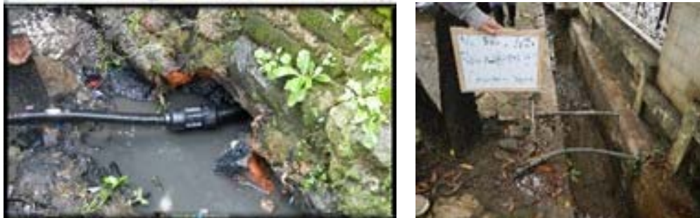
図 2-16 給水管接手部の漏水箇所
