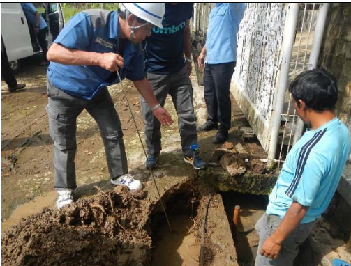
埋設水道管周辺の掘削作業
