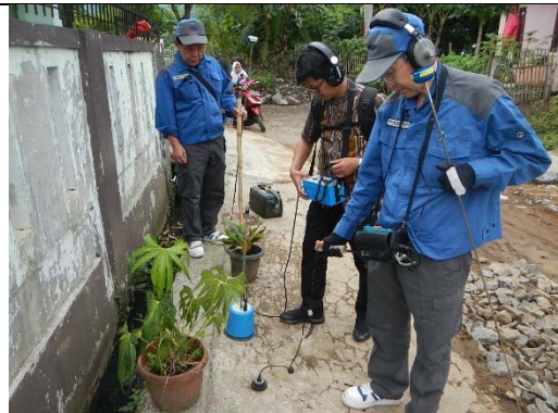
水道公社職員との共同漏水探知作業
