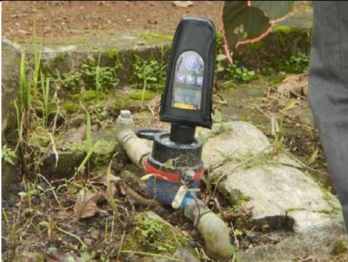
TSリークチェッカーの水道メーターへの設置
