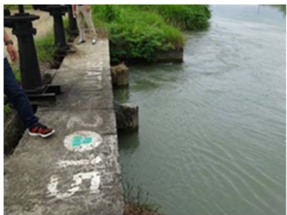
導水路から2次水路への分土工 (マニュアルのスライドゲートの場合が多く、降雨 の後は湛水を避けるためにゲートが閉められる)
