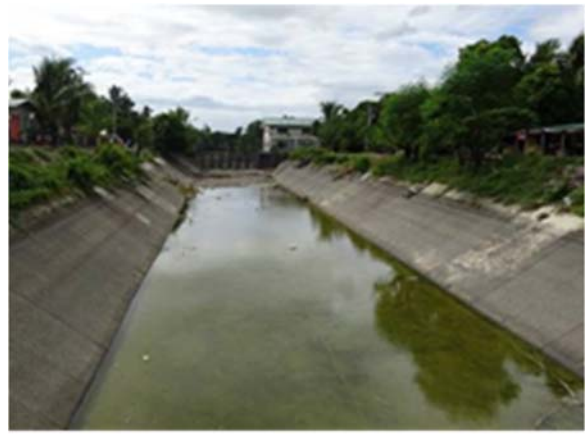
幹線水路 (ライニングされている箇所と土水路の箇所があ る)
