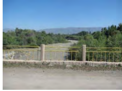
【橋上より下流側を撮影】
