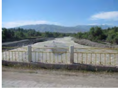
【橋上より上流側を撮影】
