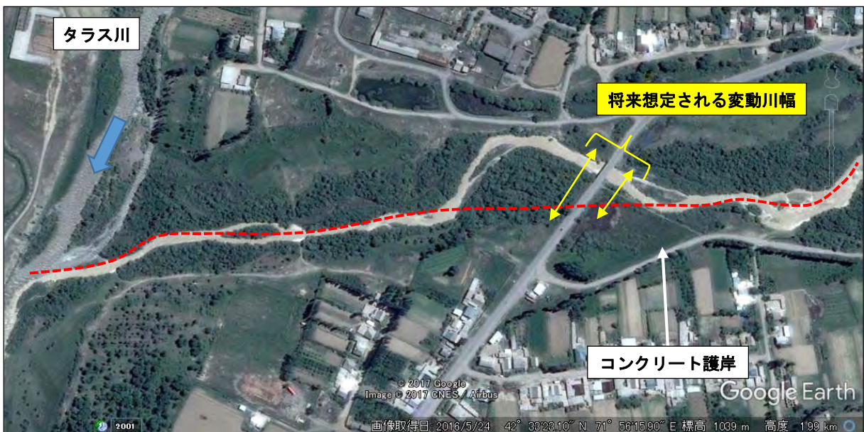
図 3-2-7 タラス-タラズ道路橋～タラス川の河道（2016年5月 Google Earth）
