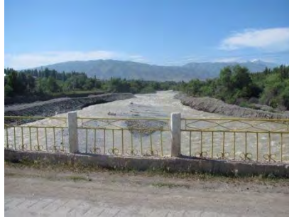
【橋上より上流側を撮影】
