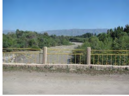
【橋上より下流側を撮影】
