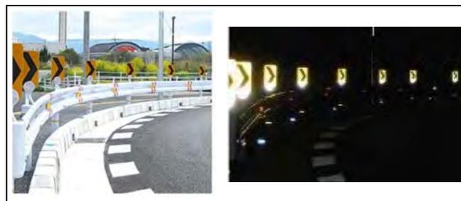
図 3-2-25 カーブの認識・逸脱対策
