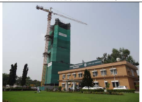
イスラマバード気象レーダー塔施設（建設中）
