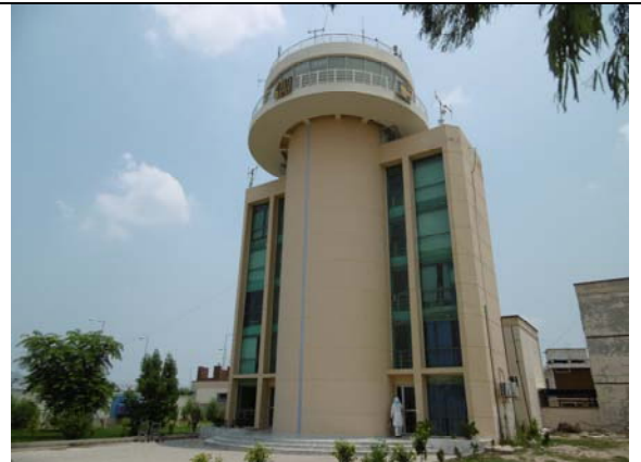
ムルタン国際空港 管制塔
