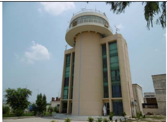
ムルタン国際空港 管制塔
