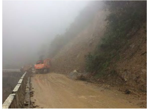
図 8.2.9 国道 8 号線の国境付近で生じた斜面崩壊
