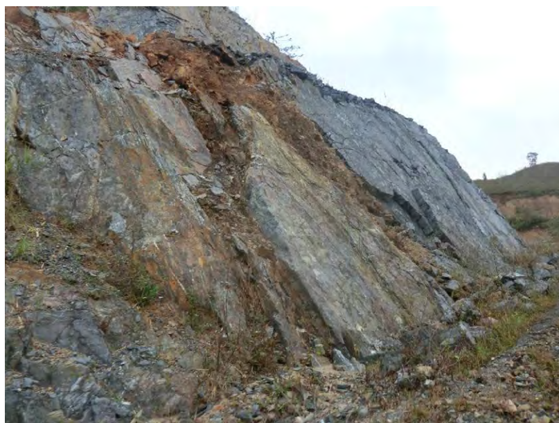
図 5.4.7 粘板岩、頁岩の流れ盤構造と斜面崩壊（プレ F/S ルートの 260KM 付近）
