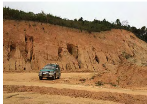
10km 付近（大規模な切り土区間）
