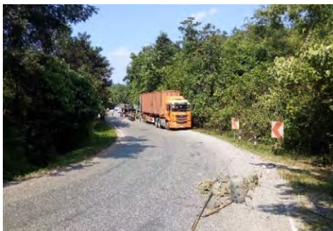
山間部（ビエンカム～ポンタン）
