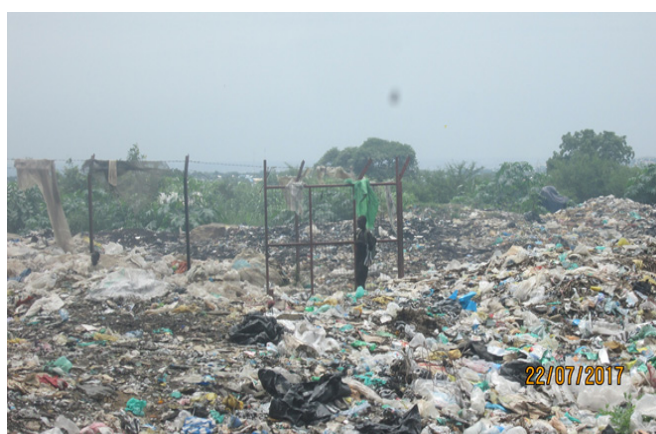
写真 3-24 破壊された処分場周辺フェンス
