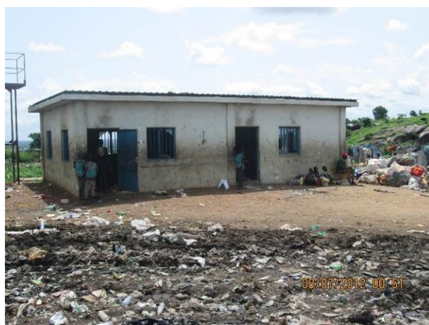
写真 3-25 管理棟は建屋のみが残っている状態 (出所) 調査団 (ナショナルスタッフ) 撮影
