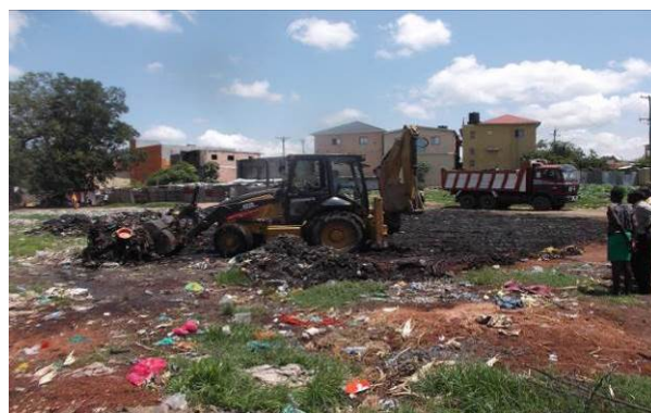
写真 3-17 重機による野焼き跡の撤去の様子
