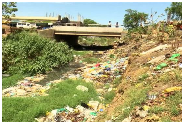
写真 3-1 住宅地沿いの河川への不法投棄
