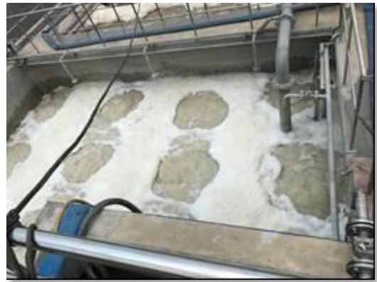
稼働確認 2(アクアブラスター稼働中:TK-03) (2017年9月)
