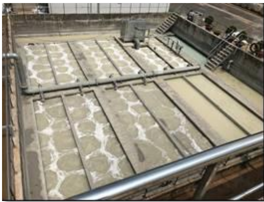
稼働確認 1(アクアブラスター稼働中:TK-01) (2017年9月)
