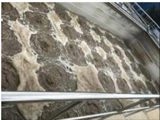
稼働確認 3(アクアブラスター稼働中:TK-11) (2017年9月)
