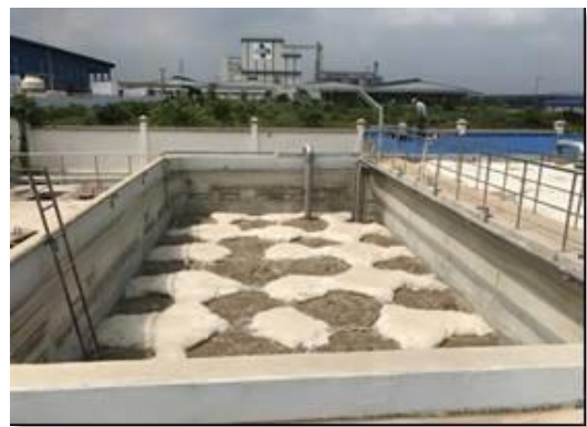
稼働確認 4(アクアブラスター稼働中:TK-13) (2017年9月)
