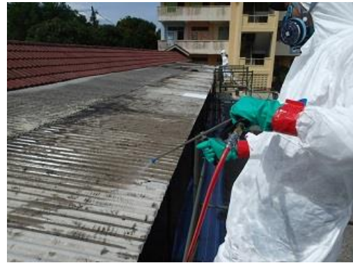
試験施工の様子
