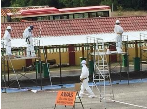
パハン州における試験施工
