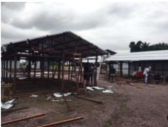
建設中のキンコレETC①
