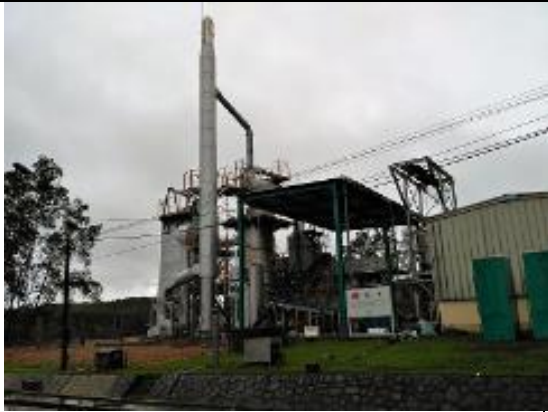
完成焼却施設全景 (2017年11月完成)
