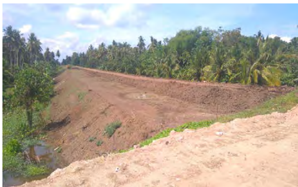
MC-2&MC-3 の分岐地点。この地点の水路堤防の高さは灌漑用水を 22.8km 先まで運ぶため約 8.5m ある。
