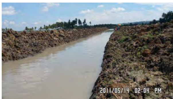
排水能力を向上させるために 2011 年に掘削した支線排水路 (LDC-PR-III) (写真は NIA-PMO の提供)
