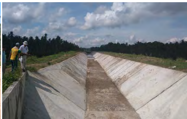
幹線水路はコンクリートライニングが計画されている。写真は MC-2、MC-3 に接続する RMC-1 EXT-1 である。
