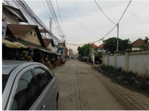
Tuol Sangkae 地区における排水路傍の住宅 (腐敗槽なく汚水を排水路に垂れ流し)
