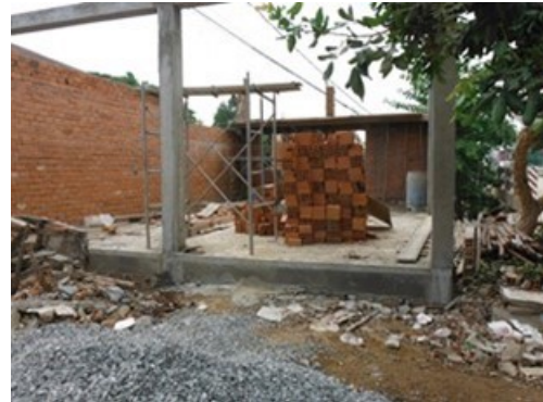
腐敗槽が設けられていない建設中の家屋
