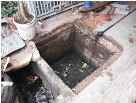
排水路の状況
