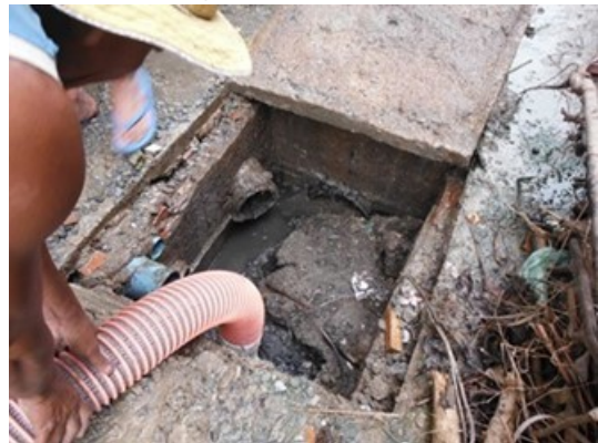
DPWT による汚水升内部の清掃作業
