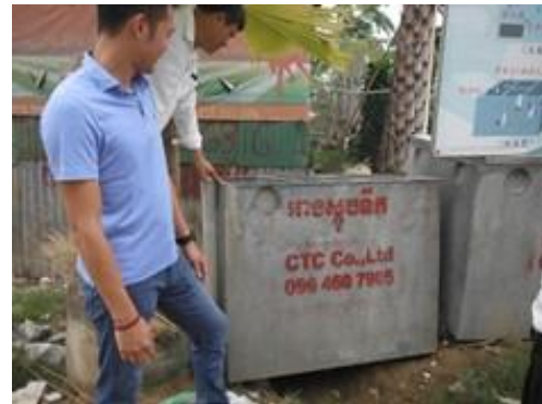
同腐敗槽外観
