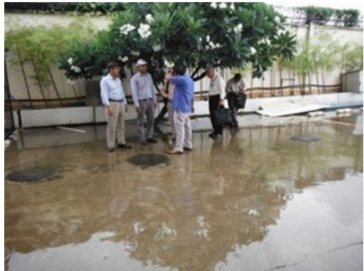
高級マンション駐車場下に設置される腐敗槽 (Doun Penh 地区)
