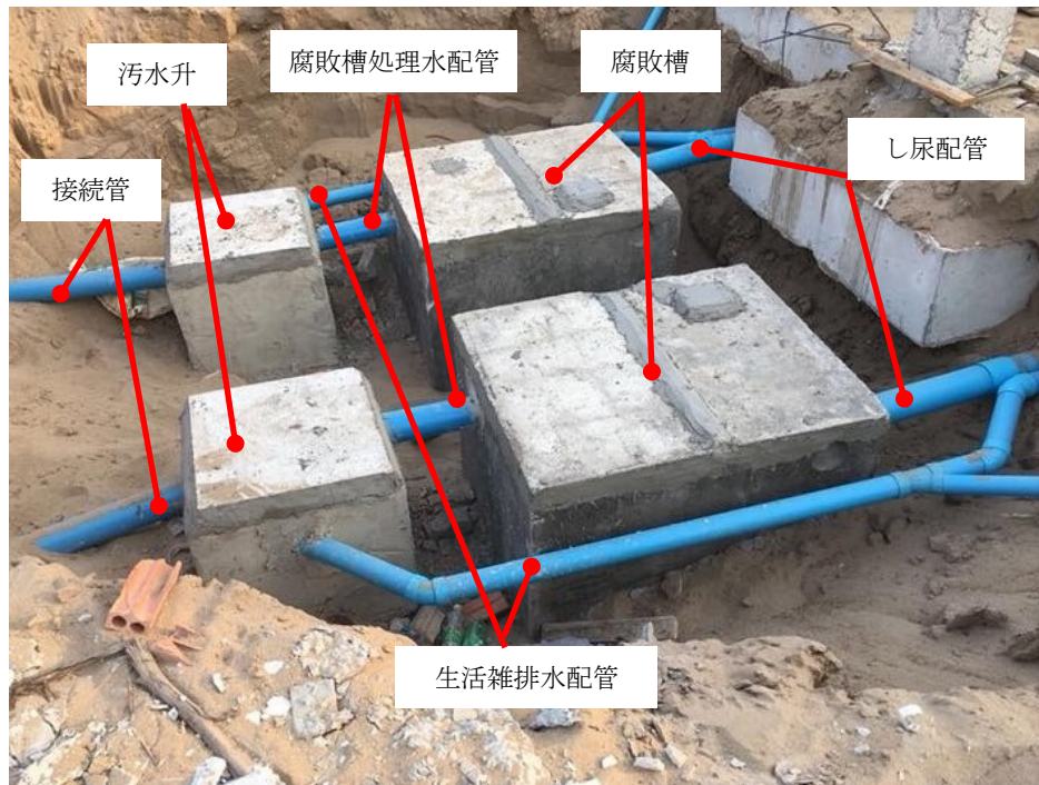
図－5 既存の分散型生活排水処理システムの例（腐敗槽が設置されている場合）
