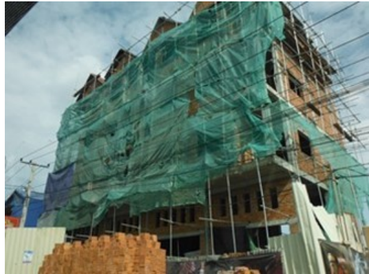
建設中の大型の建物 (Khan Sen Sok)
