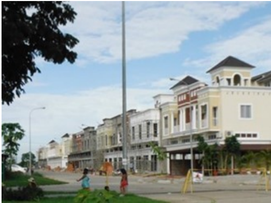
建設工事中の商業施設 (Khan Sen Sok)
