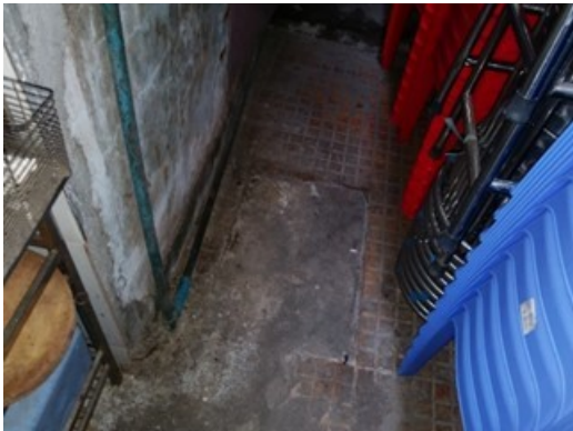
建屋床下に設置された腐敗槽 (マンホールは埋め殺し)
