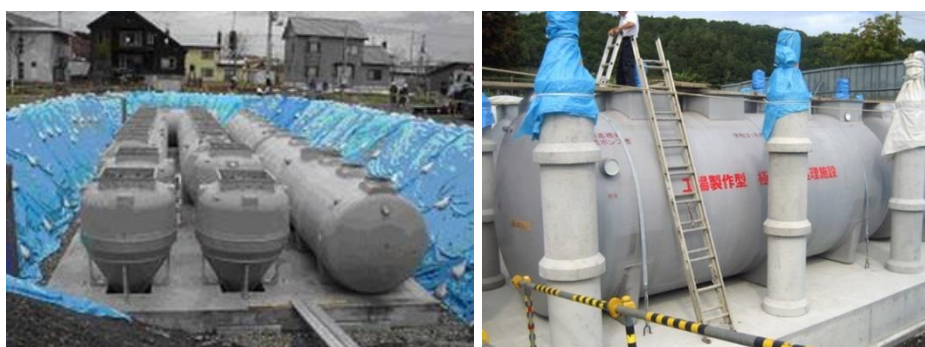
写真-9 クイックプロジェクトで設置された大型浄化槽(北海道苫前町)
