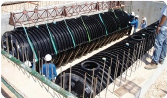
写真-5 タイ企業が販売する PE タンク製の浄化槽タイプの製品
