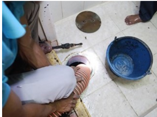
腐敗槽汚泥汲み取り作業 (建屋内トイレ床下)
