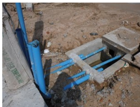
建設中の污水升（2戸分の住宅を受入れ）
