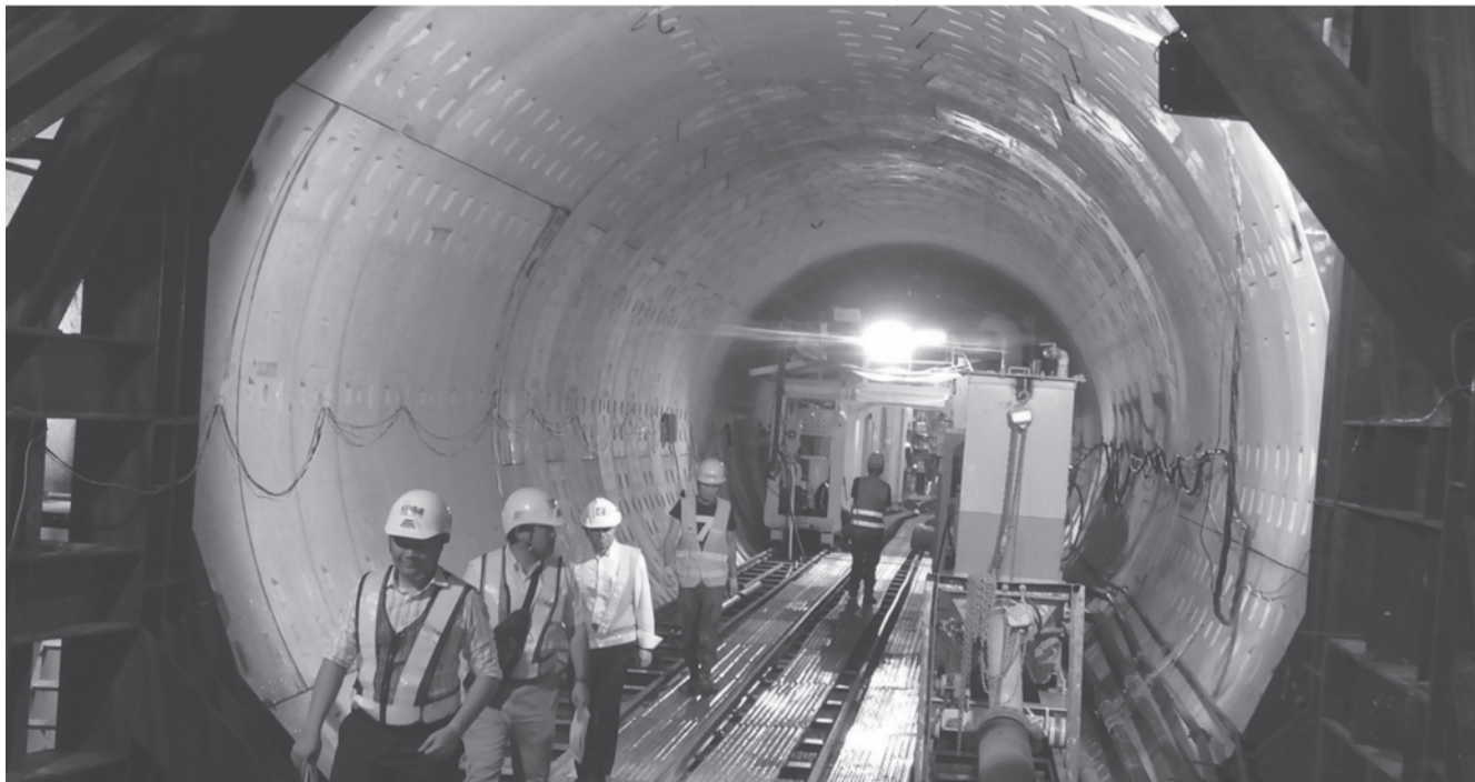
Vietnam: Obra en construcción de la Línea 1 del Ferrocarril Urbano de la Ciudad de Ho Chi Minh, entre las estaciones Opera House y Ba Son. Un túnel subterráneo se está construyendo con el método de de túnel SHIELD.
