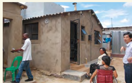
Ces maisons en cours de rénovation seront équipées de rampes pour les personnes handicapées.
