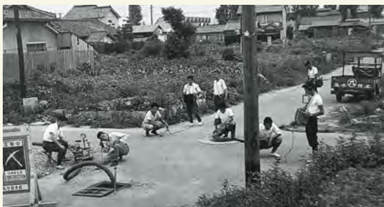
Contrôle des fuites d'eau par les services d'eau et d'assainissement de la ville de Nagoya après la deuxième guerre mondiale, vers 1949.
