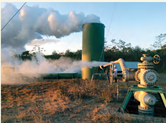
Test de puits géothermiques
