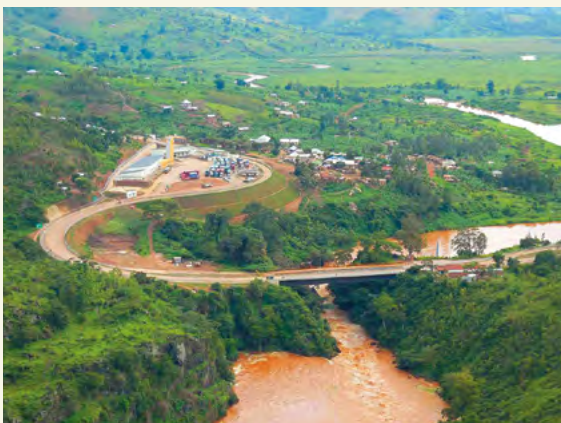
Le pont international de Rusumo et le PFGU à la frontière entre la Tanzanie et le Rwanda
