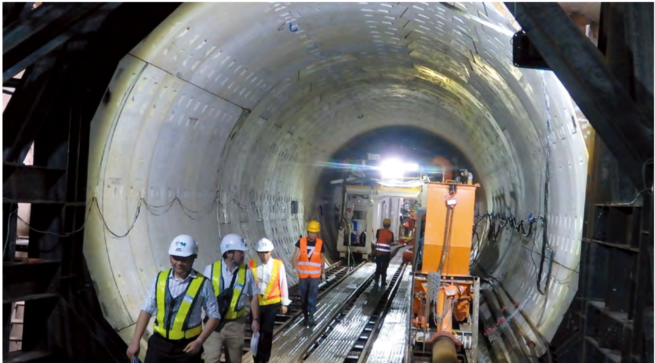
Vietnam : Un chantier de construction de la ligne 1 du réseau ferré urbain de Ho Chi Minh-Ville, entre les stations Opera House et Ba Son. Un tunnel souterrain est en cours de construction avec la méthode du creusement au bouclier.
