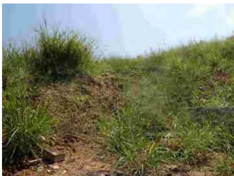
Point No.1 背後斜面の状況
