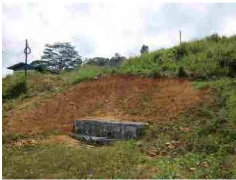
Point No.4 背後斜面の整形状況
