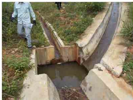
土砂は除去されている
