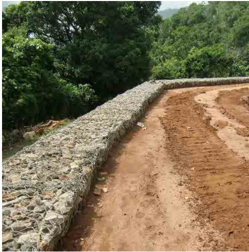
布団カゴの施工状況(11月)
