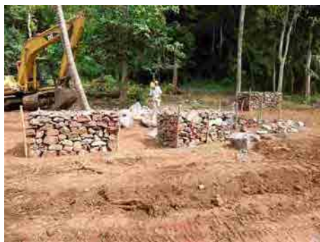
転石の小割り状況
