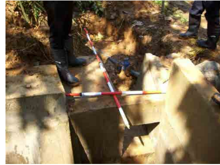
TypeA 流末接続柵(既設水道パイプ確認)
