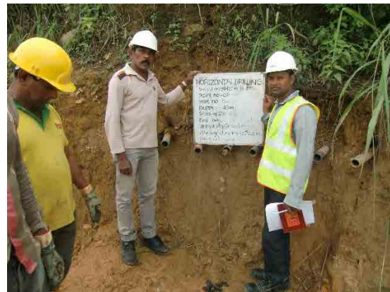
No. 4 検尺状況 (挿入完了)
