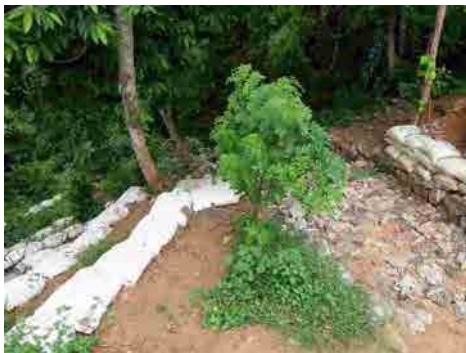
水路工側部に設置された土のう (上方より)
