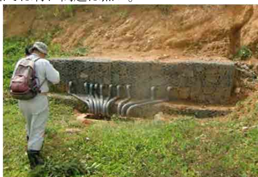
Point6の横ボーリング孔口パイプの破損は補修済み
