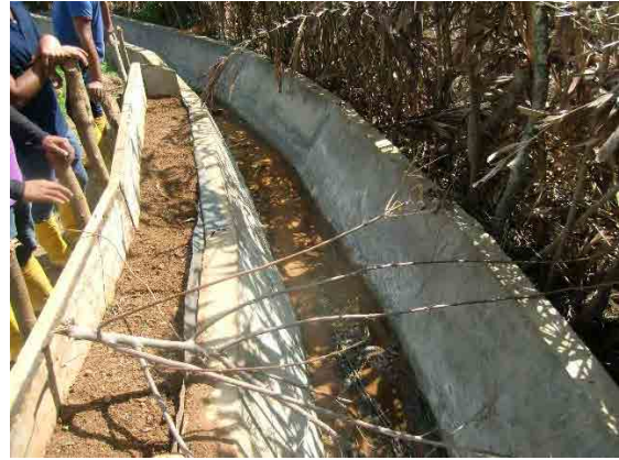
水路工施工状況(施工中)
