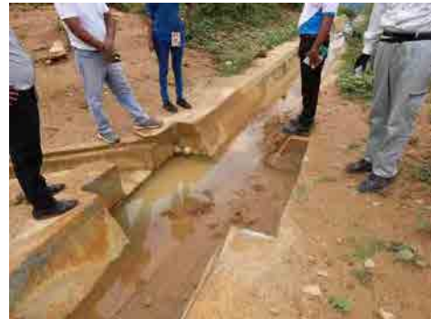
最下部の柵への土砂の流入状況
