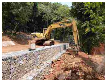
布団カゴの設置状況
