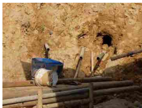
Point No.4 ボーリング工からの集水状況
