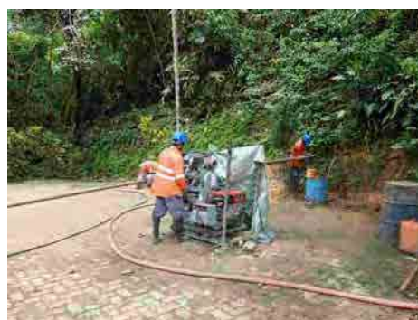
ボーリングマシンの使用状況
