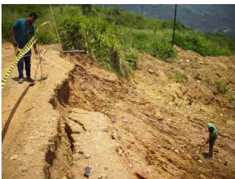
現場事務所前の段差計測
