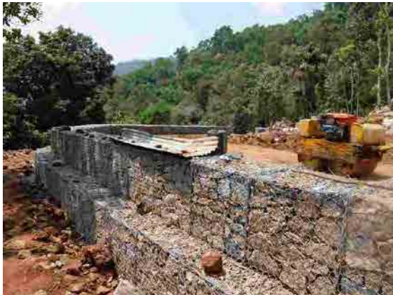
布団カゴの施工状況(9月)
