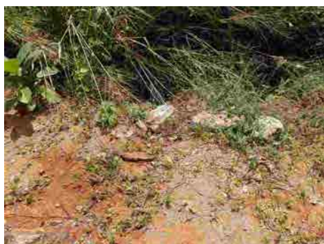
盛土部法肩の状況
