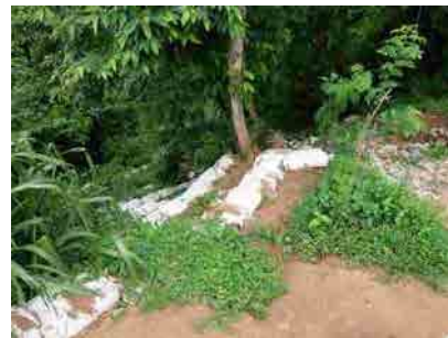
水路工側部に設置された土のう (左:5月、右:6月)
