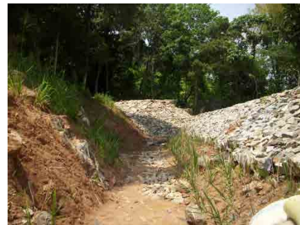
植栽工施工状況(ポケット内部)
