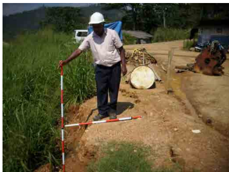
現場事務所前の段差
