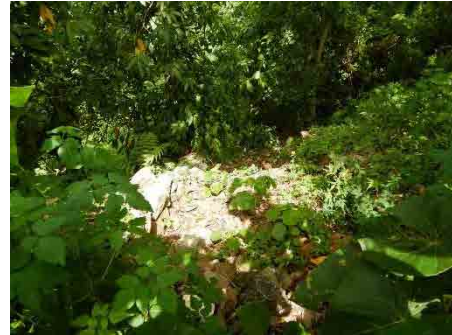
水路工の状況（変化なし）
