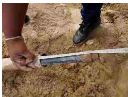
PVC パイプによる検尺状況 (挿入完了)
