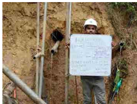
No.8: PVC 挿入完了
