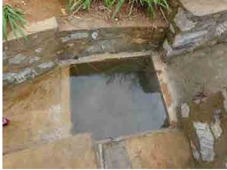
集水柵補修後の状況
