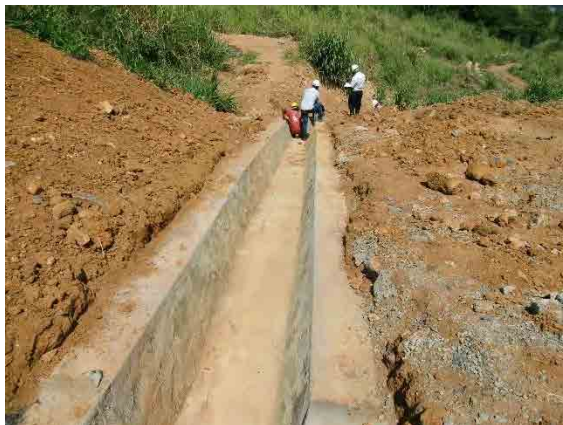
TypeG 水路(追加)施工状況
