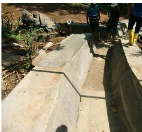
水路工施工状況(施工完了)
