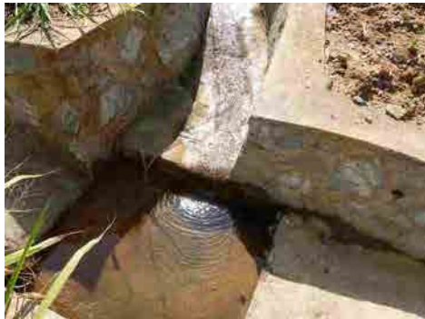
集水柵への流入の状況
