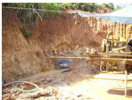
Point6 水平ボーリング施工状況
