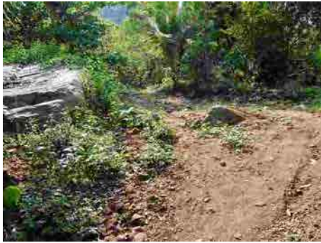
仮設道路の状況
