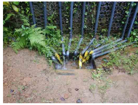
横ボーリングの排水機能が維持されている
