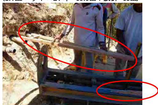
ボーリングの間隔と角度を決定する受注者自作の計測器具
