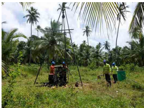
ボーリングマシンの使用状況
