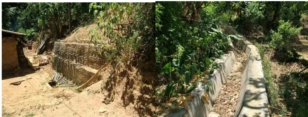
横ボーリング工施工状況
