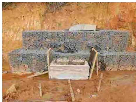
Point No.6 ボーリング施工箇所全景
