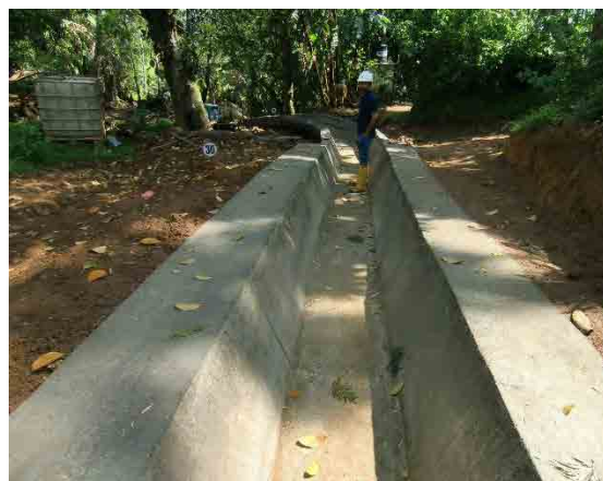
水路工施工状況(施工完了)
