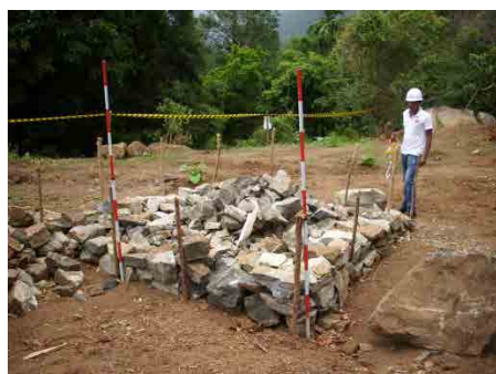
転石の小割り状況
