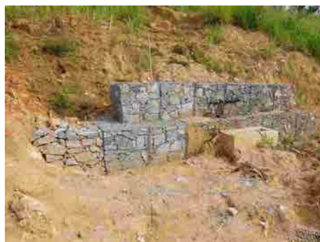
Point No.1 ボーリング施工箇所全景
