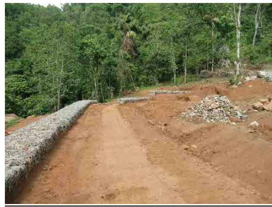
布団カゴ及び盛土の施工状況(10月)
