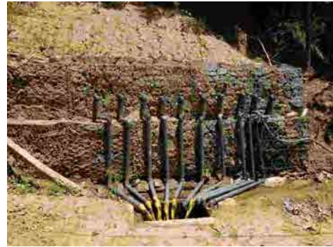
集水ボーリング工全景
