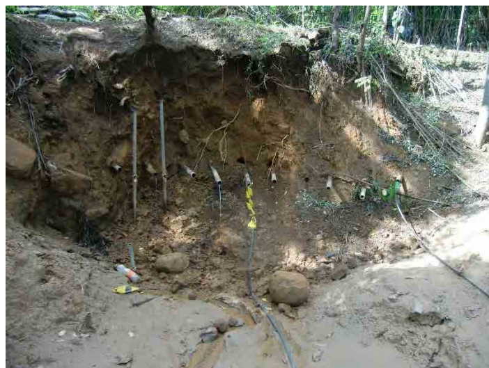
ボーリング集水状況
