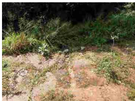
盛土部法肩の状況 (左)
