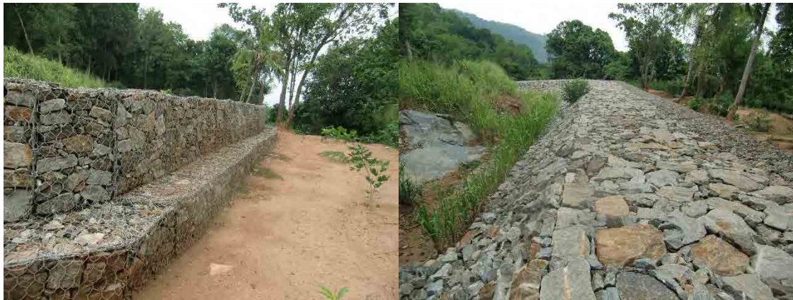
谷側布団カゴの施工状況
