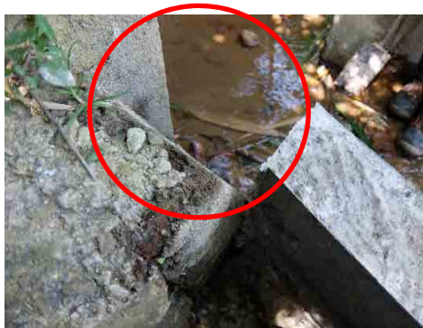
柵下部の水路工の補修後の状況（検査時）
