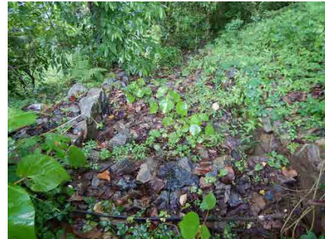
水路工の状況 (変化なし)
