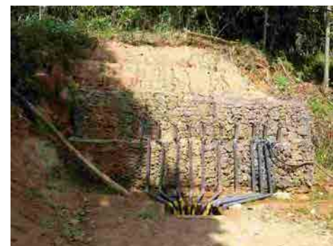
集水ボーリング工全景
