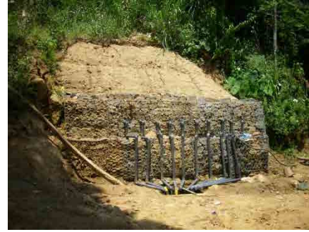
集水ボーリング工全景
