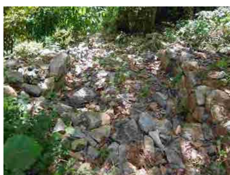
水路工の状況
