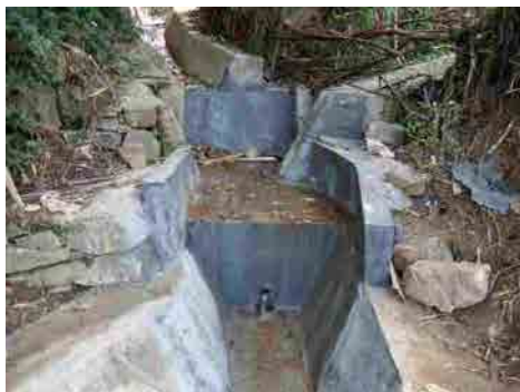
樹下部の水路工の補修後の状況
