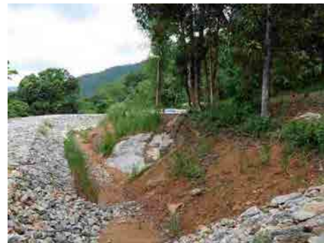
植栽工の状況
