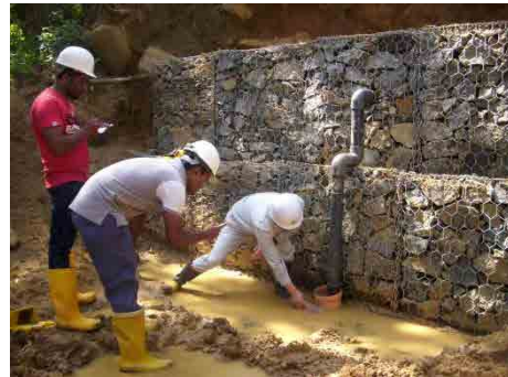
ボーリング集水量計測状況
