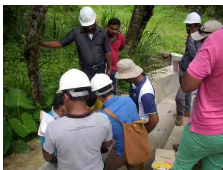
水路工出来形確認
