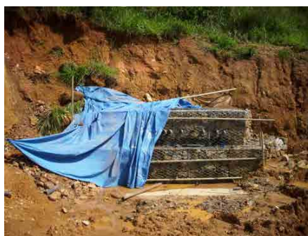
ガビオン工完成状況 (Point5)
