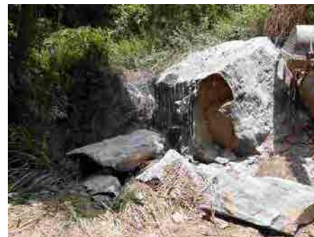
静的破碎剤の使用による岩塊の破碎
