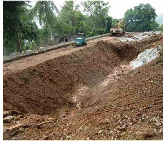
ピット掘削の状況(11月)
