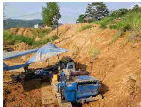
Point No.4 ボーリング施工箇所全景
