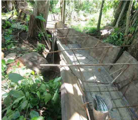
水路工施工状況(施工中)
