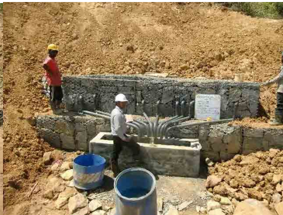
BH-4 布団カゴ工完成状況
