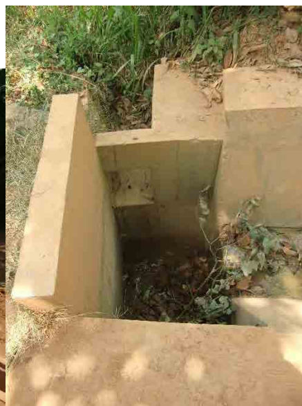
TypeA 水路流末コンクリート工
