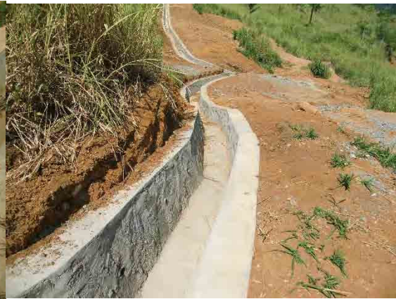
TypeF 水路(追加)施工状況
