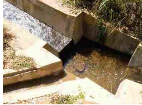
最下部の柵への土砂の流入状況
