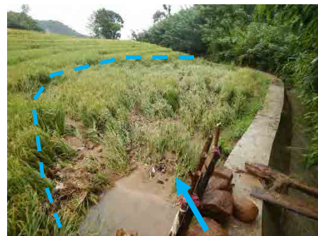
水路からの越流による水田の被害 (Location No.15) 2018 年 5 月の状況
