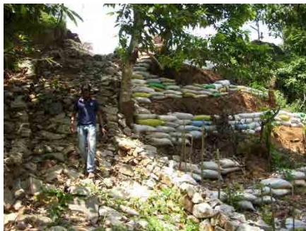
水路工側部に設置された土のう積
