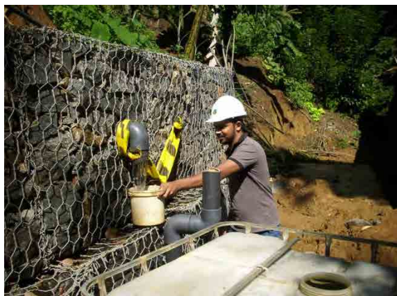
ボーリング集水量計測状況
