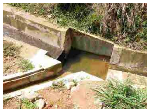
集水柵の土砂撤去後の状況
