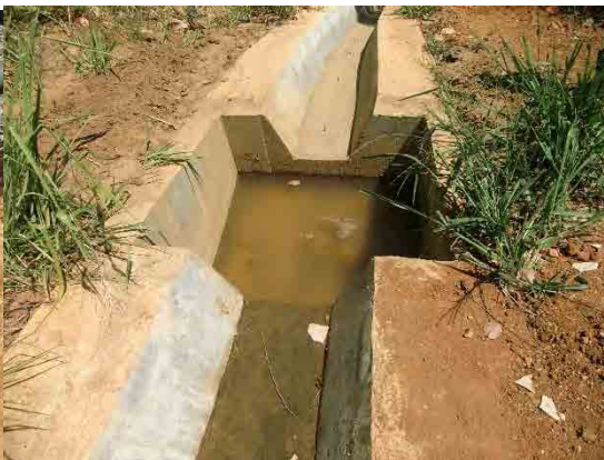
Type2 集水柵施工状況
