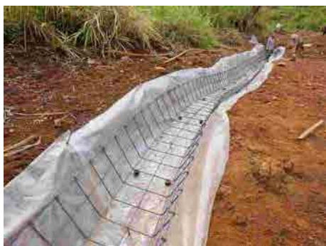
防水シートと鉄筋の設置
