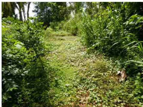
盛土部法肩の状況（変化なし）
