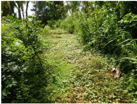
盛土部法肩の状況（変化なし）
