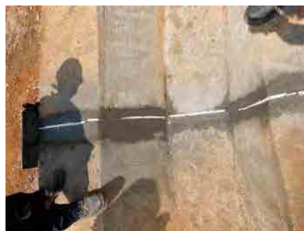
再施工された目地
