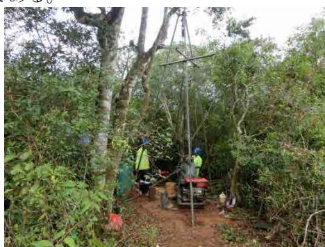
ボーリングマシンの使用状況
