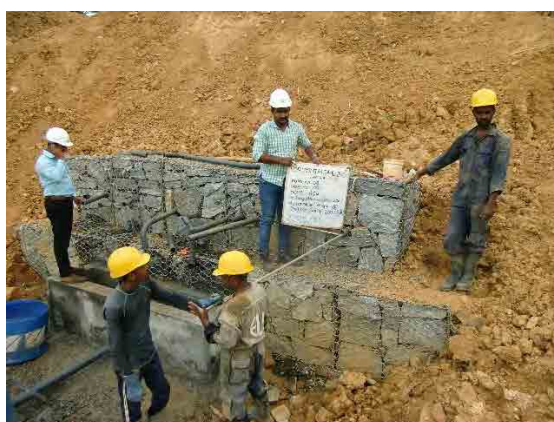
横ボーリング BH-4 施工完了状況
