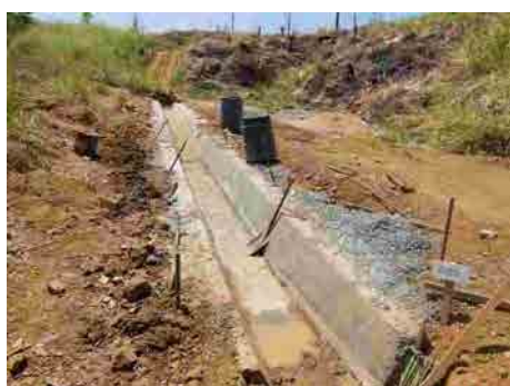
水路工の完成 (CH:0m-20m)
