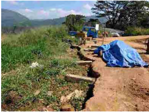
盛土の滑動状況（左：現場事務所前の亀裂、右：Point 4 の埋没状況）
