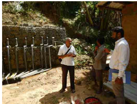
自治体職員への対策工維持管理の留意点指導状況（2018年6月20日）
