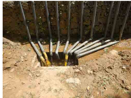
横ボーリングの排水機能が維持されている
