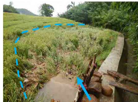
水路からの越流による水田の被害 (Location No.15)
