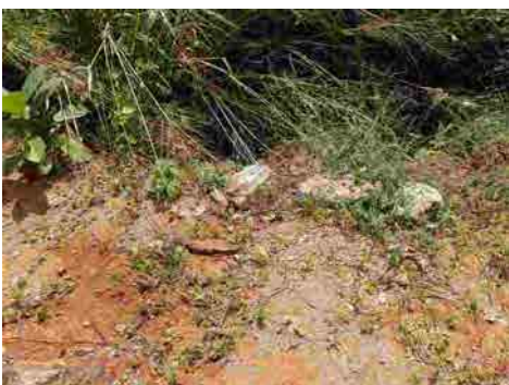
盛土部法肩の状況
