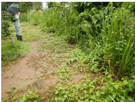
盛土部法肩の状況 (変化なし)
