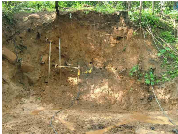
ボーリング集水状況
