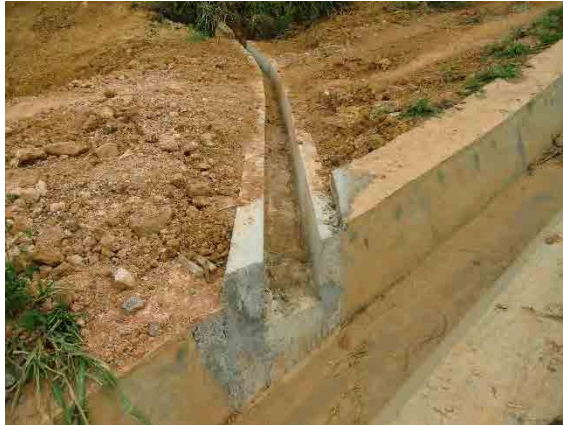
TypeE 水路(追加)施工状況
