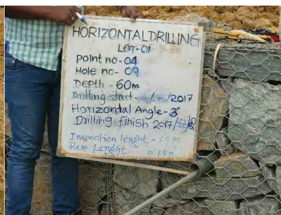
N0.9 孔検尺状況
