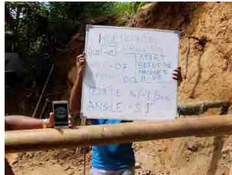
No.7: 掘削角度の確認 (5.1° , 設計 : 5° )
