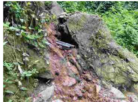
水平ボーリング孔からの集水状況
