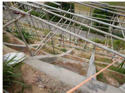
鉄筋の挿入状況（プレートの設置はこれから）
