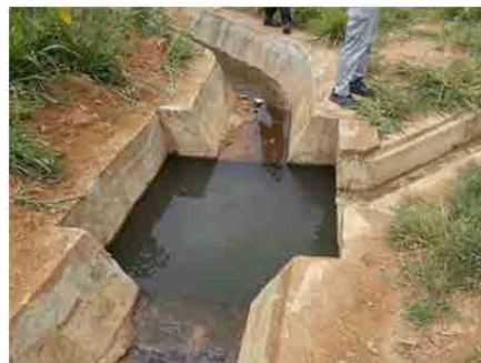
土砂は除去されている
