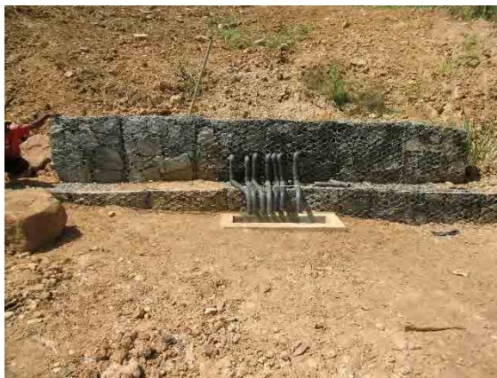
BH-1 布団カゴ工完成状況
