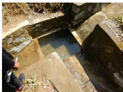
最上部の集水桝に堆砂は生じていない
