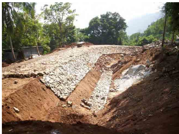
盛土工および表面被覆工
