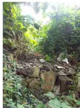
水路工の状況（変化なし）
