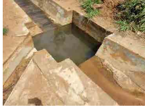
集水柵土砂撤去後の状況
