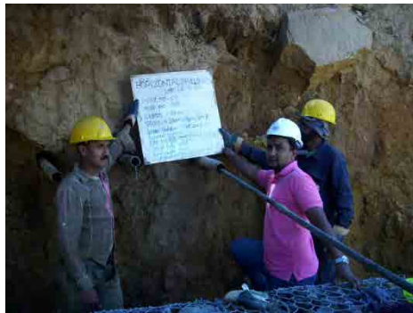
水平ボーリング施工延長確認
