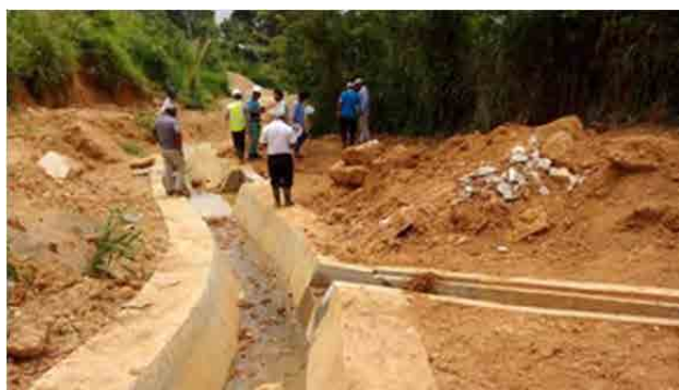
TypeE 水路接続部分施工後
