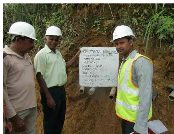
No. 2 検尺状況 (挿入完了)
