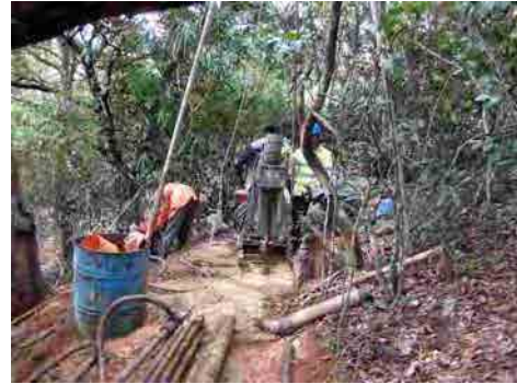
ボーリングマシンの使用状況
