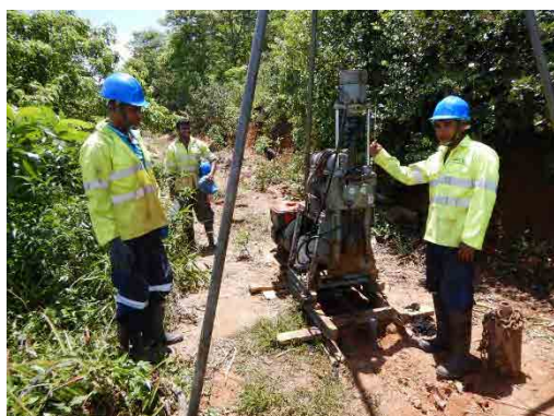
ボーリングマシンの使用状況
