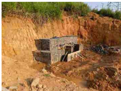
Point No.6 ボーリング施工箇所全景
