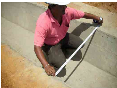
水路工出来型の確認
