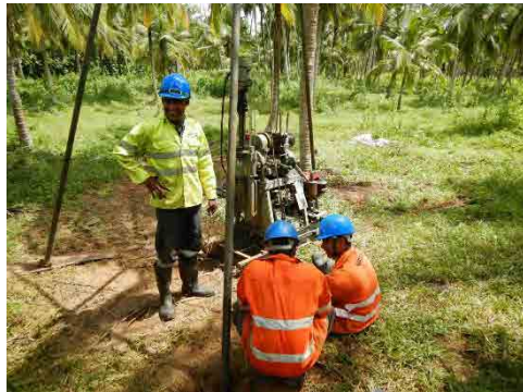
ボーリングマシンの使用状況
