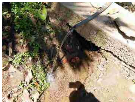
水路から地すべり地内に素掘り水路で水を流している状況
