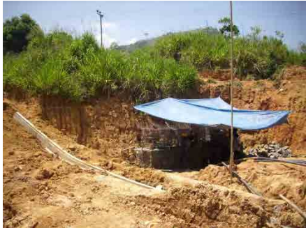
PointNo.6 水平ボーリング施工箇所全景
