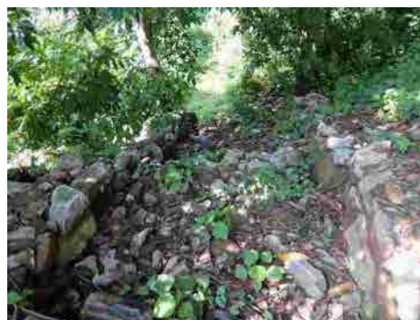
水路工の状況
