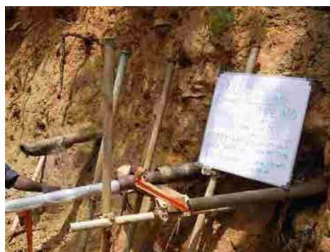
1 本目の PVC パイプ挿入
