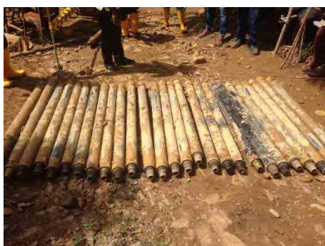
ロッドの数量による掘削深度の確認 (1.7m/ロッド×27本=45.9m : 設計 45m)
