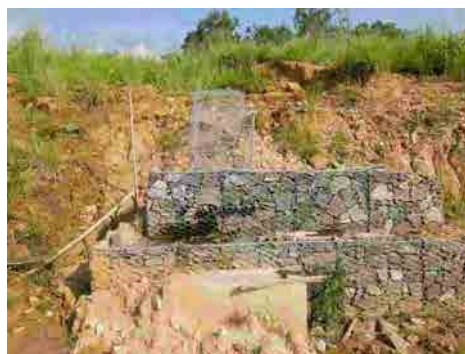
Point No.1 ボーリング施工箇所全景
