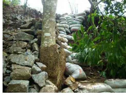
水路工補強状況（土のう積）
