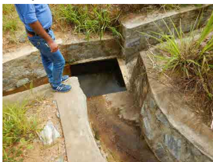
最上部の集水柵に堆砂は生じていない
