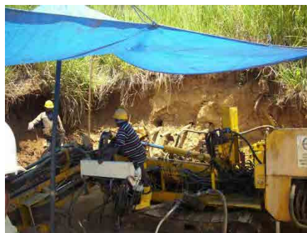
Point4 における削孔作業状況
