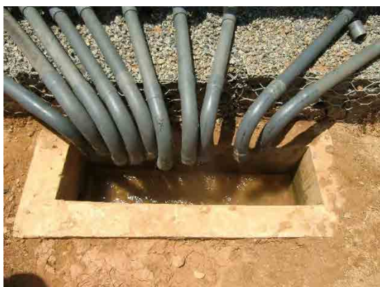
Type1 集水柵施工状況
