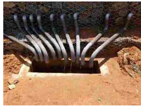
No.6 集水ボーリングの土砂撤去後
