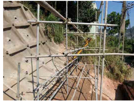
ボーリングマシン設置状況
