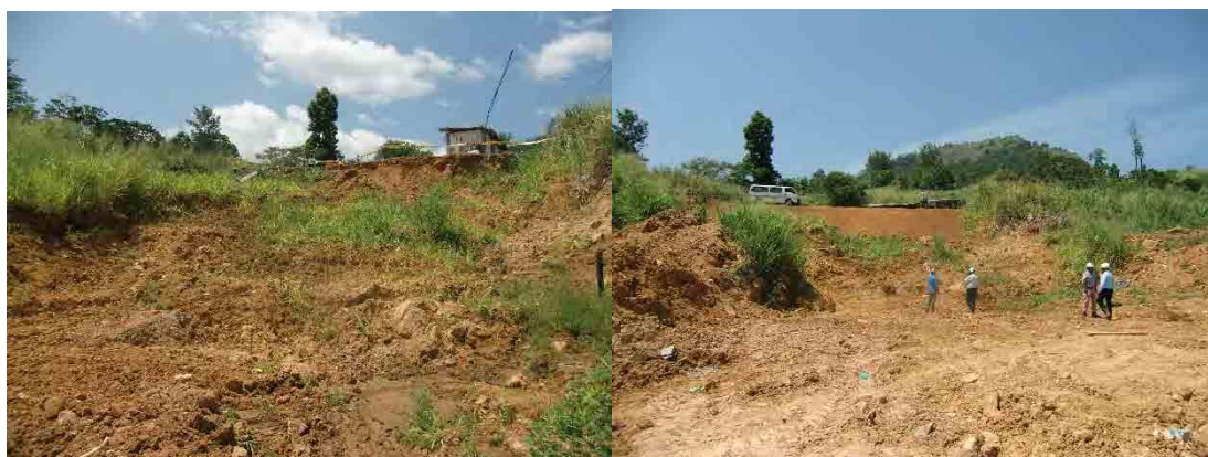
BH-4(旧)の急斜面の状況(施工前)
