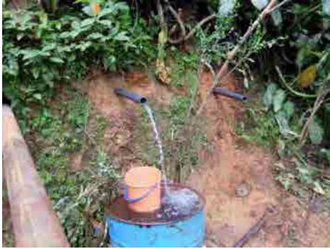
水平ボーリング孔からの集水状況
