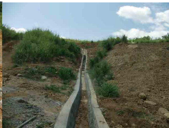
TypeG カスケード水路(追加)施工状況
