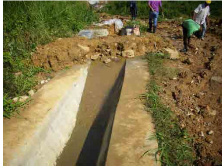
TypeB 水路施工済み区間
