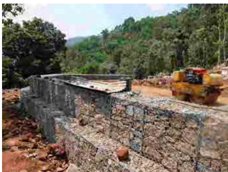
布団カゴの設置状況
