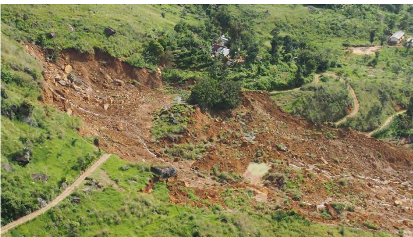
滑落崖 移動土塊の残存状況
