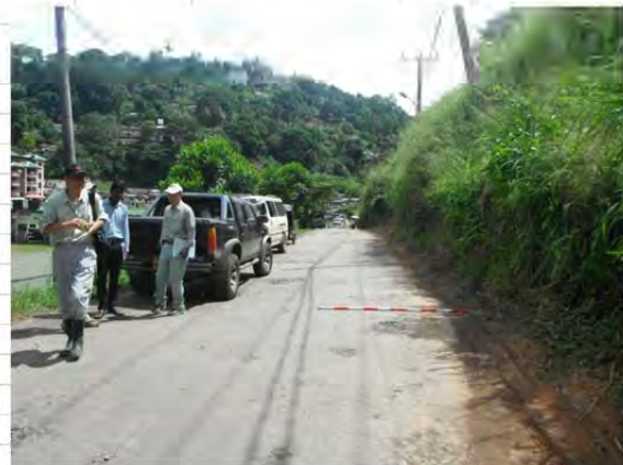
下方斜面の末端部の道路
