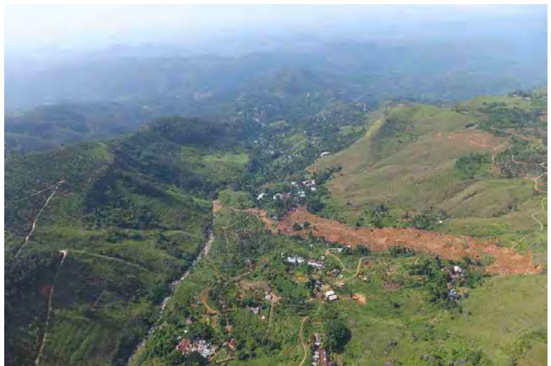
写真-3 下流側保全対象
