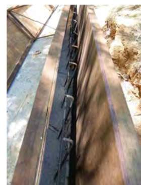
鉄筋の不整配置が修正された状況
