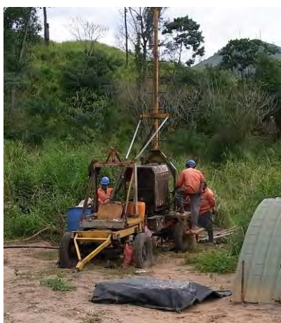
C/P によるボーリング作業状況
