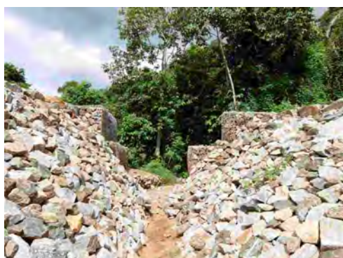
開口部の状況
