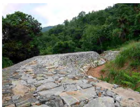
土堰堤の状況(天端)
