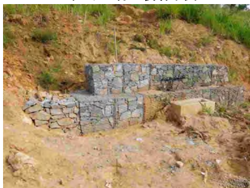
ボーリングポイント No.1 の切土
