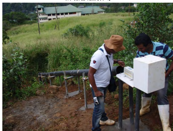
地盤伸縮計の設置
