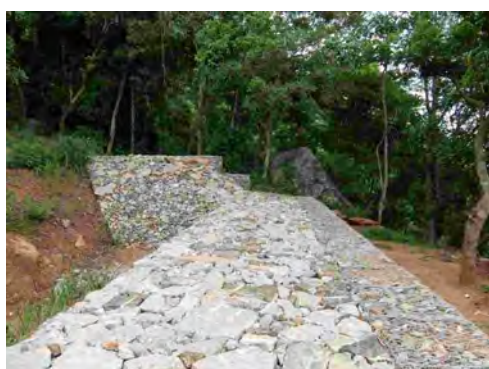
土堰堤の状況(天端)
