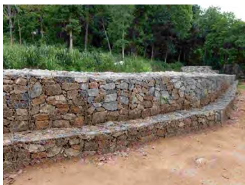
土堰堤の状況(斜面下方)
