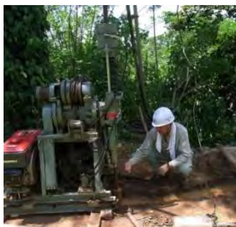
調達したボーリングマシンでの掘削状況
