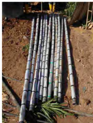
フィルター材の装着不良
