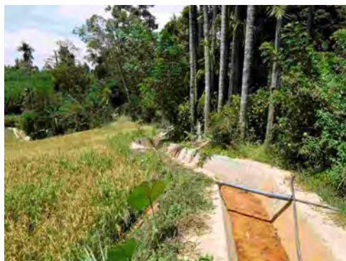
スムーズな線形に修正された水路
