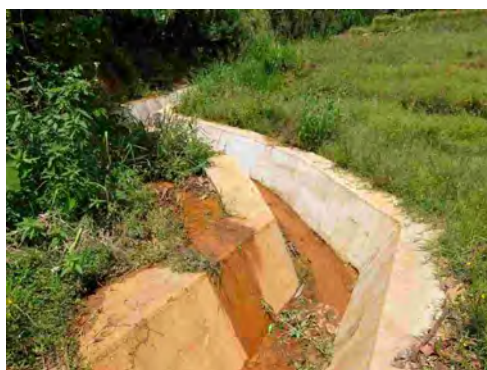
スムーズな線形に修正された水路
