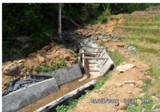
不自然な線形の水路
