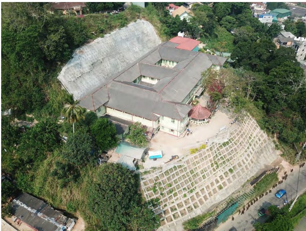
図 6.4 対策工施工後の状況(2018年3月23日撮影)
