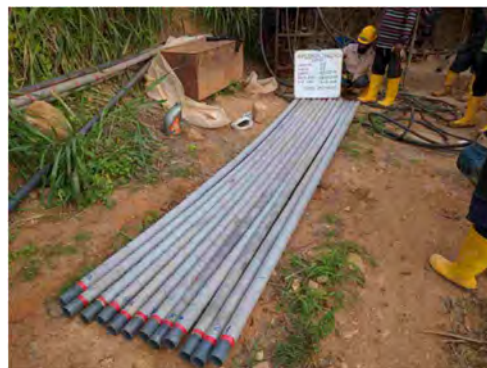
修正されたフィルター材の装着
