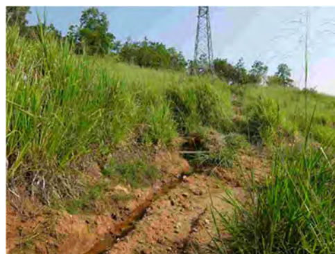
ボーリングポイント No.1 上方斜面の湧水
