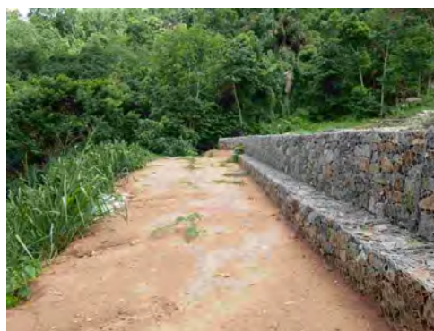
土堰堤の状況(斜面下方)
