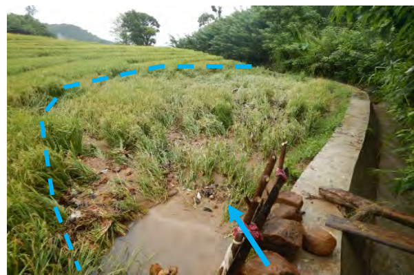
図 5.9 水路から溢水した状況
