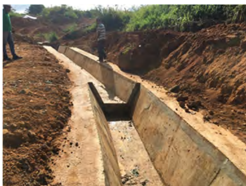
水路工の断面変化点 (Type A (600-900) と Type B)
