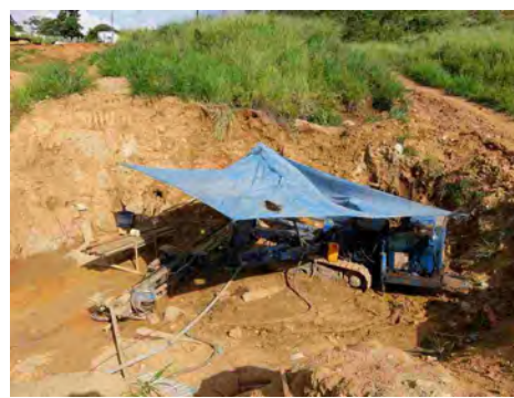
ボーリングポイント No.4 の切土(新)
