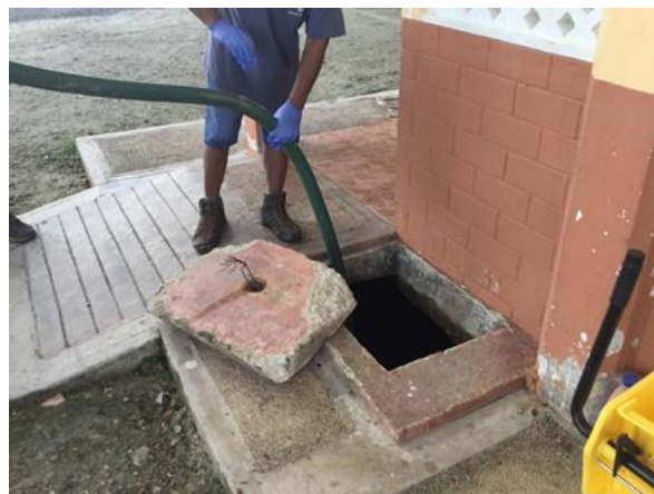
セプティックタンク汚泥回収作業の様子
