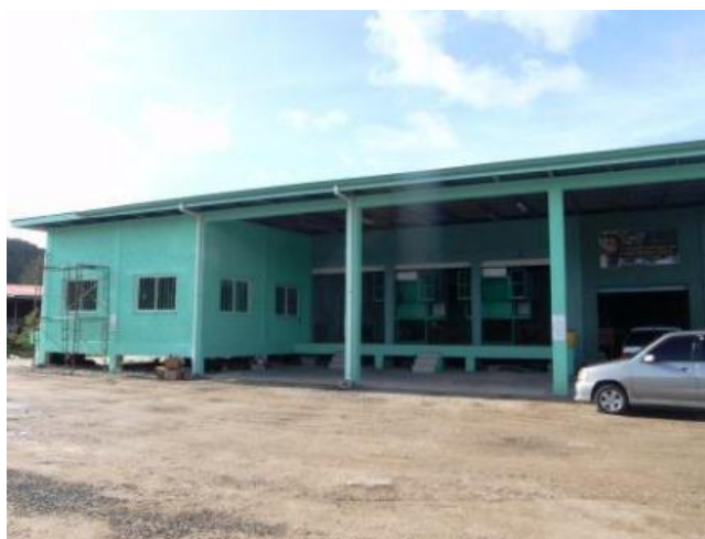
リサイクルセンター外観
