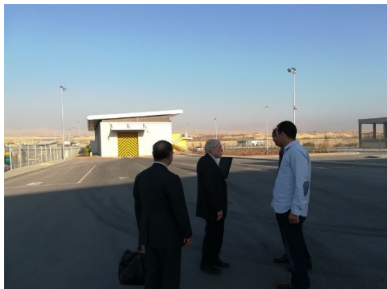
イスラエル側 KHB 国境での 新スキャナ施設
