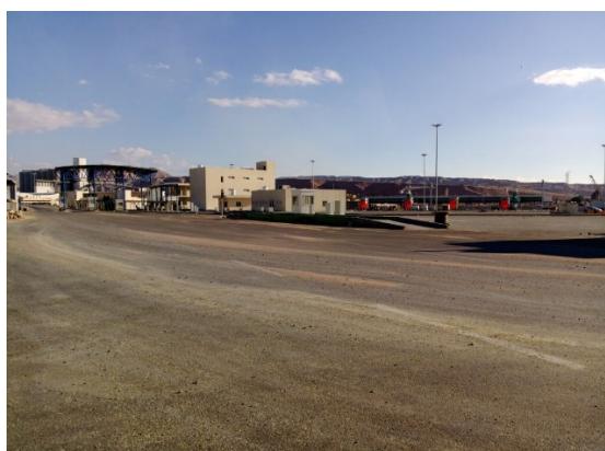
建設中のアカバ港コンテナターミナル
