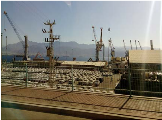
エイラト港外観
