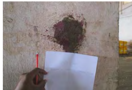
柱コア抜き後のモルタル補修
