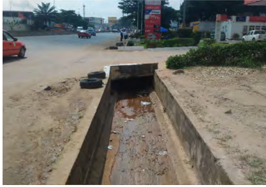
Figure 7.3.6 Carrefour Riviera 3 Rigole en U actuelle du côté est (nord) et passage à l'extrémité de l'écoulement actuel
