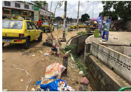
Figure 7.3.6 Carrefour Riviera 3 Rigole en U actuelle du côté est (nord) et passage à l'extrémité de l'écoulement actuel
