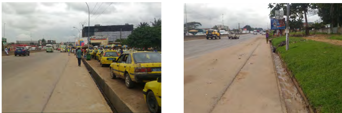
Figure 7.3.10 Carrefour Palmeraie Rigole en U actuelle du côté est
