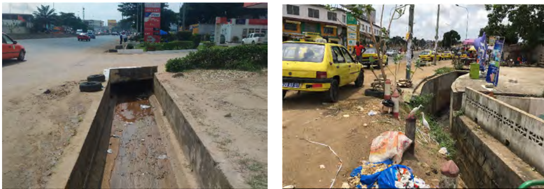
図 7.3.6 リビエラ 3 交差点 東側既設 U 型水路（北）と既設流末水路
