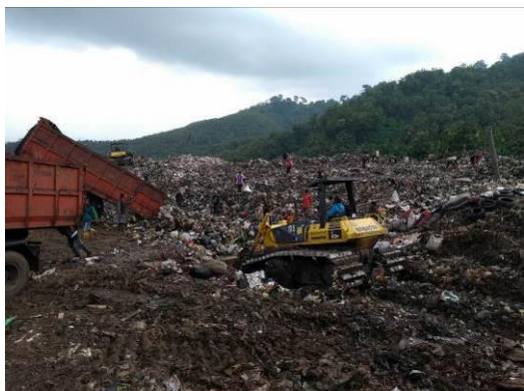
バンドン市最終処分場（サリムクティ） 重機による廃棄物敷均し
