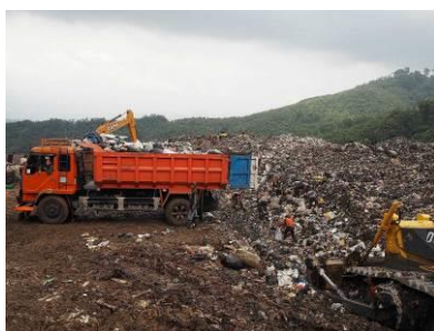
ダンプトラックによるごみ搬入
