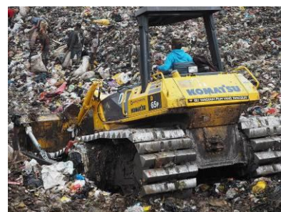
ブルドーザによるごみの敷均し
