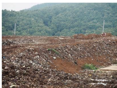
埋立完了部分の覆土とガス抜き管
