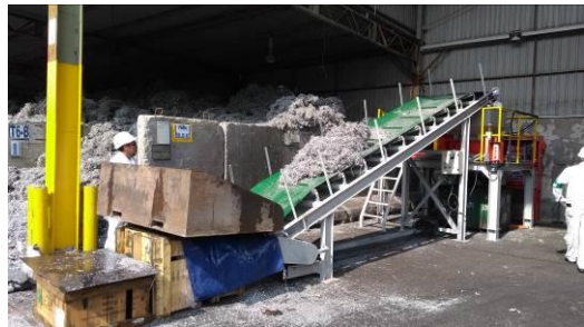
工業団地（既に導入された破砕機）
