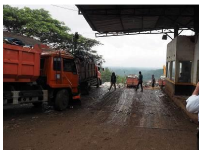
処分場出入り口（右が管理棟）
