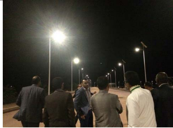
Novembre 2017 : Visite une site de la lampe solaire
