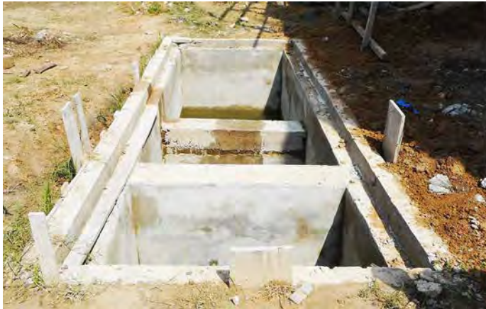
図 2-2-1 新管理棟の浄化槽（工事中の写真と断面図）
