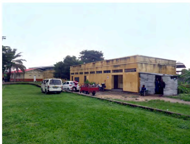
写真 -15：事業サイト内の保健棟 相手国側負担により撤去予定。
