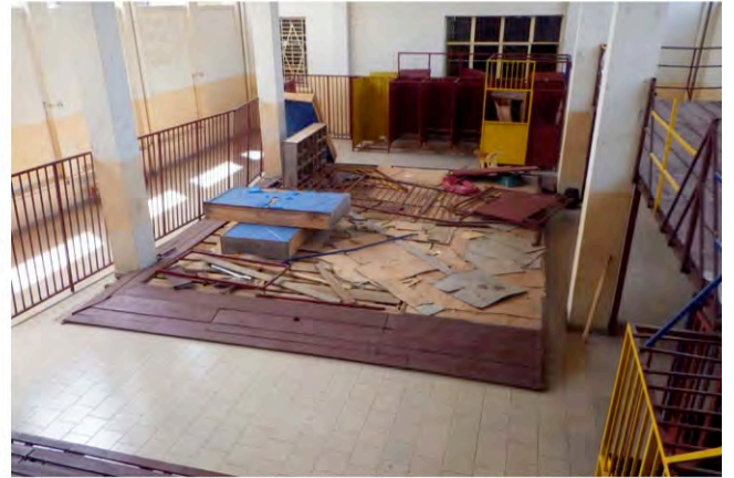
写真 -7：アテネ・デ・ラ・ゴンベ中高等学校内柔道場 2017年現在床の改修工事中。 広さは7.2m x 6mで狭いうえに四隅に柱が有り 大変危険である。
