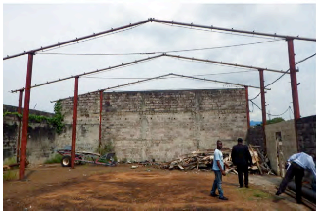
写真 -1：チャング柔道クラブ (ドン・ボスコ技術中学校) 柔道場 チャング地区内のドン・ボスコ技術中学校 キャンパス内の柔道場。 屋根が撤去された施設の中に有り、10m x 10m のエリアにおが屑が敷きつめられている。
