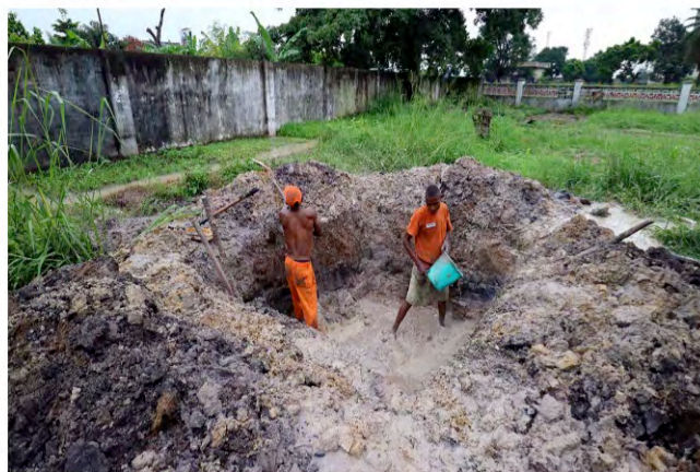
写真 -13：PNC 内事業サイト 事業サイト内の掘削状況。
