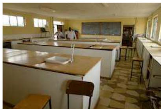
E2/Motsekuoa 理科実験室。損傷が著しく、機材も限られている。
