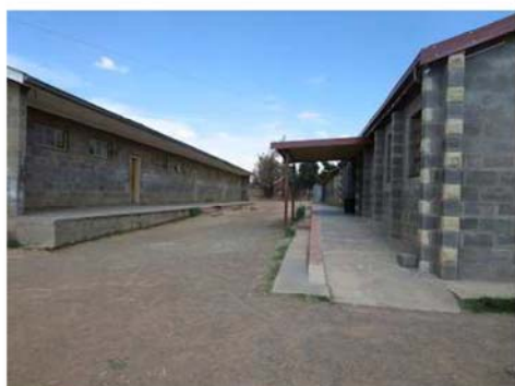
E1/Abia 完成したばかりの校舎(右端)。スロープが整備されているが手摺りはない。
