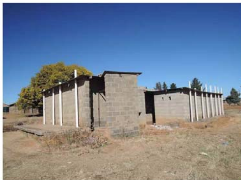
E1/Abia 便所棟。バリアフリーとなっておらず、車椅子での利用は困難。
