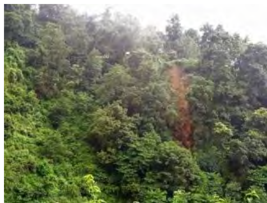
図 8.2.2 現道谷側斜面の崩壊地
