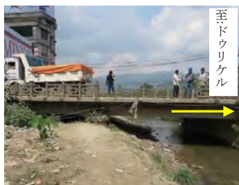
(1) パンヤティ川にかかる 17m の橋
