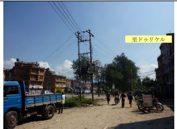
写真-8 : スルヤビナヤック市街地 (起点部) (ROW 内の移設を必要とする電柱や鉄塔)
