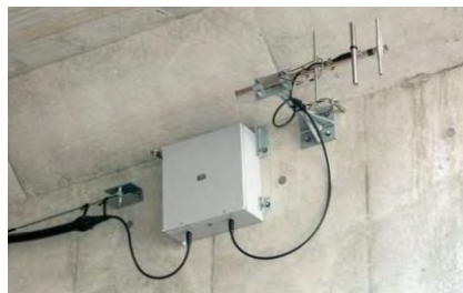
写真 11.6-10 無線通信補助設備
