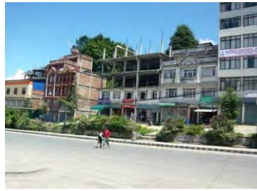
(2) 道路用地外に整列した家屋（左側）
