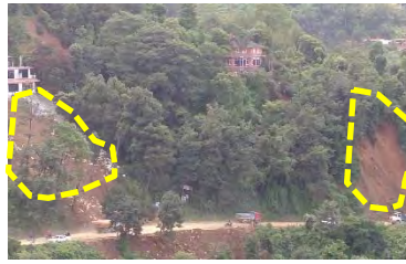
(5) サンガ峠での斜面崩壊 (2015年8月27日)
