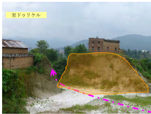
写真-21: ドゥリケル付近切土面
