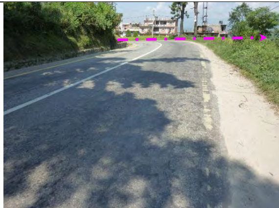
写真-11 : 起点側バイパス分岐予定地付近
