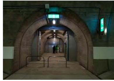
避難通路（避難連絡坑）
