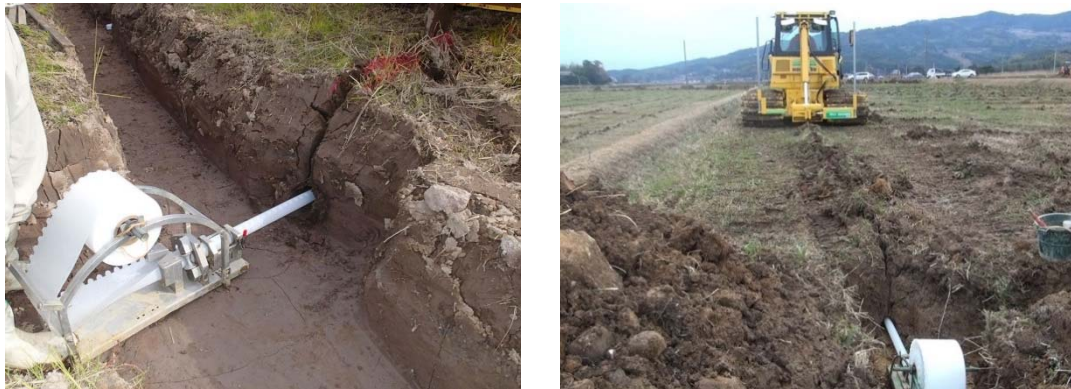
図 2.3 モールドレーナーによるシートパイプ敷設状況
