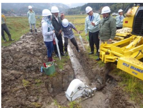
本邦受入活動（施工現場視察）
