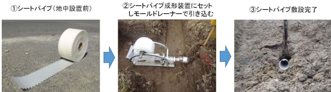
図 2.1 シートパイプ敷設の流れ
