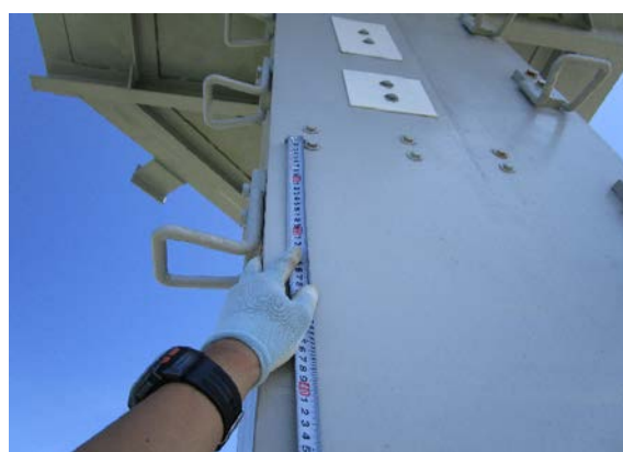
アンテナ取付部ボルト穴の寸法確認
