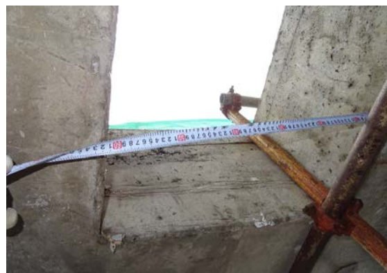
タワーハウス（アンテナ搬入時に通過すると想定される通り抜け穴）
