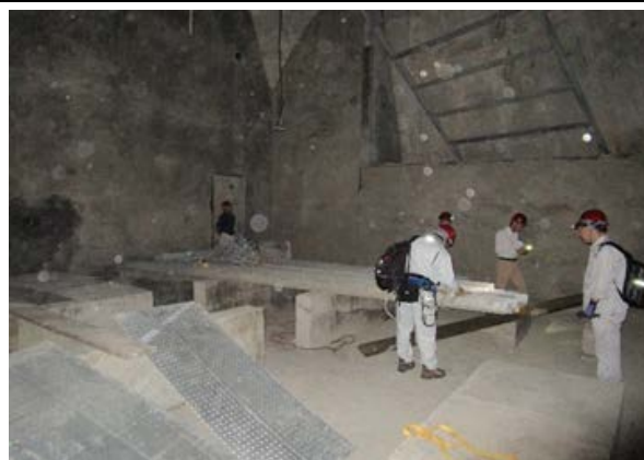
タワーハウス内（貯水フロア）のケーブル敷設ルート確認
