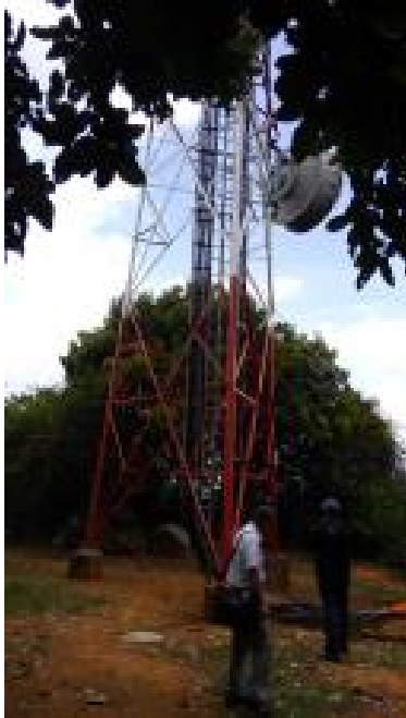
鉄塔調査 (バドゥーラ)
