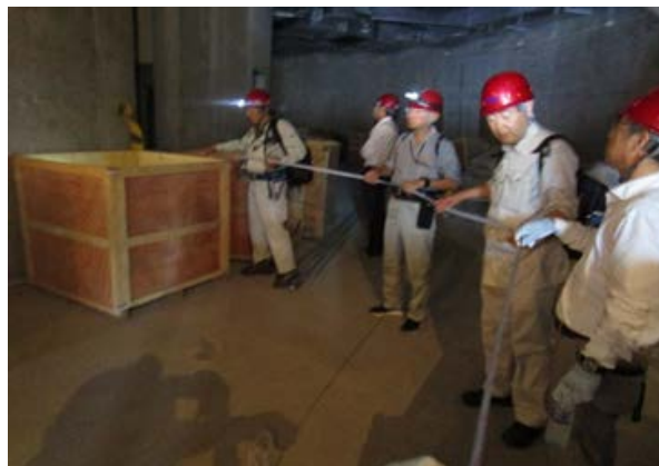
タワーベース内のフィーダーケーブル搬入スペース確認
