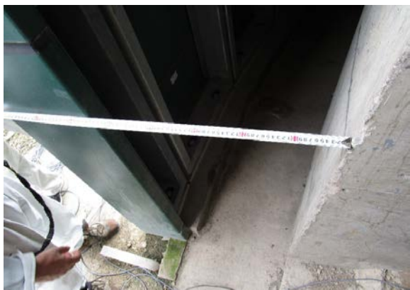
プラットフォームのケーブル類敷設箇所寸法の確認
