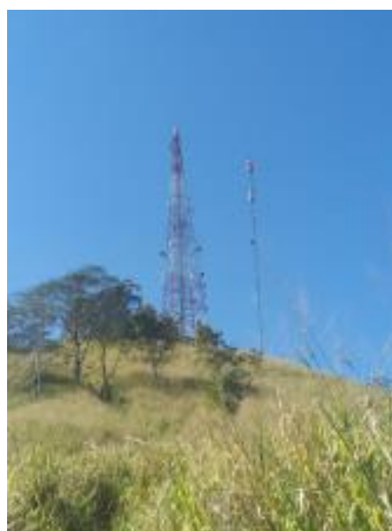
アンテナ鉄塔 (写真中央) (ハンタナ)
