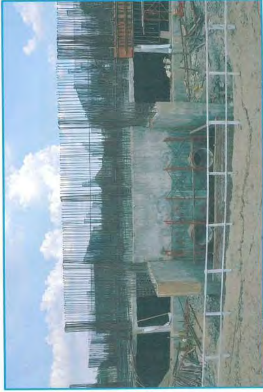
Clear Water Reservoir နေရာတွင် Tiebeam နှင့် Wall များအားတွန့်တစ်လောင်းနေပုံ
