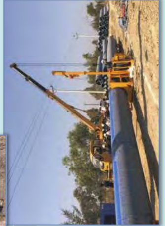
40" Ø HDPE ပိုက်လိုင်းဆက်သွယ်ခြင်း လုပ်ငန်းဆောင်ရွက်နေပုံ
