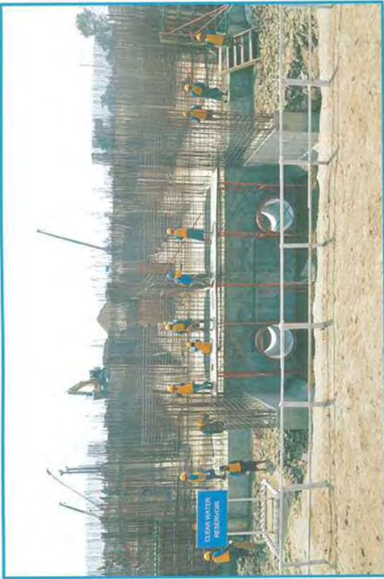
Clear Water Reservoir နေရာတွင် Tiebeam နှင့် Wall များအားတွန့်တစ်လောင်းနေပုံ
