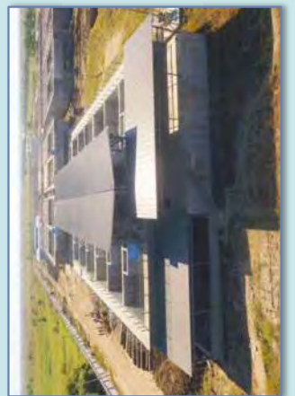
Rapid Sand Filter ၏ Super Structure အပိုင်းတည်ဆောက်ခြင်း လုပ်ငန်းဆောင်ရွက်နေပုံ
