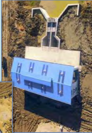
Lift Pumping Station တည်ဆောက်ခြင်း လုပ်ငန်းဆောင်ရွက်နေပုံ
