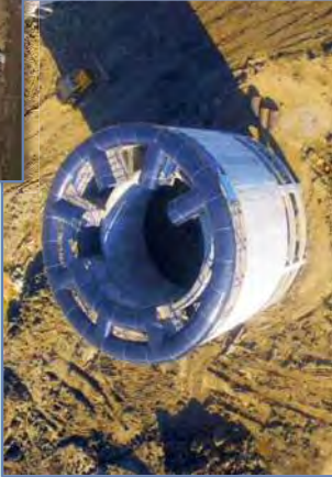
Dividing Well ၏ Super Structure အပိုင်းတည်ဆောက်ခြင်း လုပ်ငန်းဆောင်ရွက်နေပုံ
