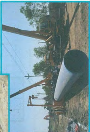
40"Ø HDPE ပိုက်လှီးဆက်သွယ်ခြင်း လုပ်ငန်းဆောင်ရွက်နေပုံ
