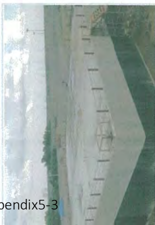
Clear Water Reservoir တွင် Floor Slab conc; လောင်းရန် ပြင်ဆင်ထားပုံ
