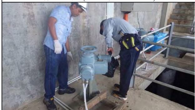
ろ過池弁の据付確認 (2016年8月31日)
