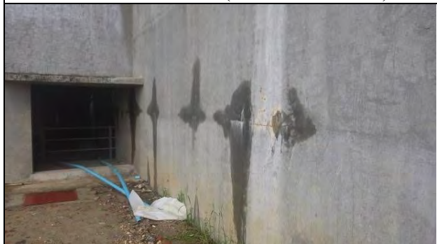
水張試験中のろ過池の外壁 (2016年10月28日)
