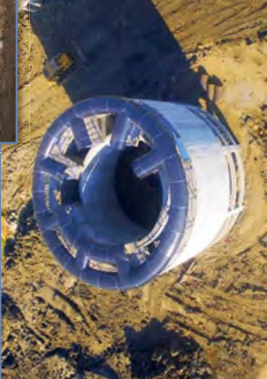
Dividing Well ၏ Super Structure အပိုင်းတည်ဆောက်ခြင်း လုပ်ငန်းဆောင်ရွက်နေပုံ
