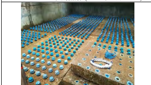
ストレーナ設置状況 (2017年8月29日)
