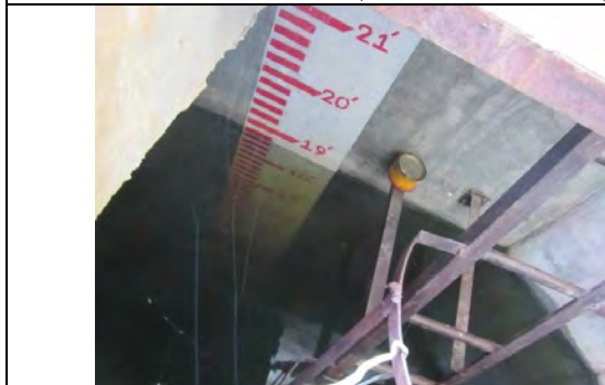
浄水池の水張試験 (2016年9月28日)
