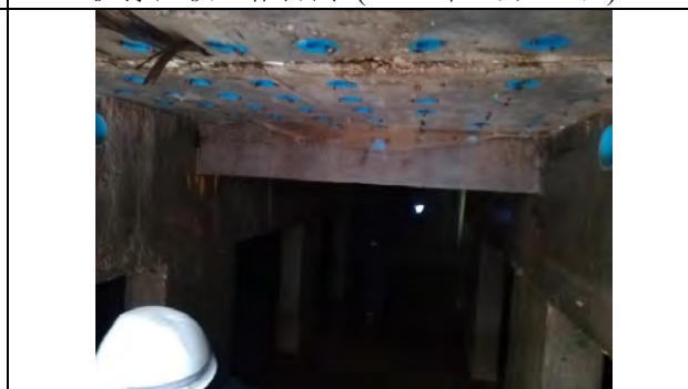
ろ過池床下の合同検査 (2017年8月29日)
