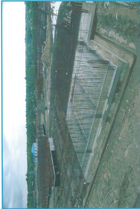
Rapid Sand Filter တွင် Base Slab အားကွန်ကရစ်လောင်းခြင်းလုပ်ငန်း ဆောင်ရွက်နေပုံ
