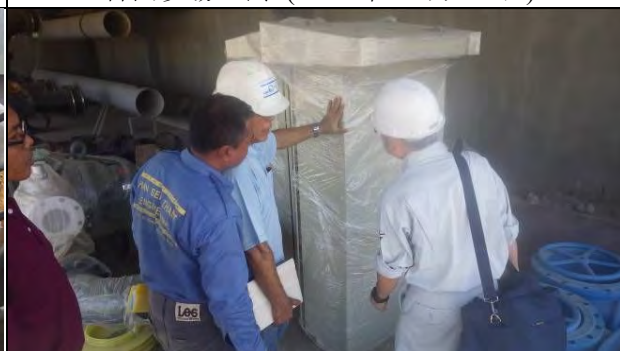
完了検査 (2016年5月18日)
