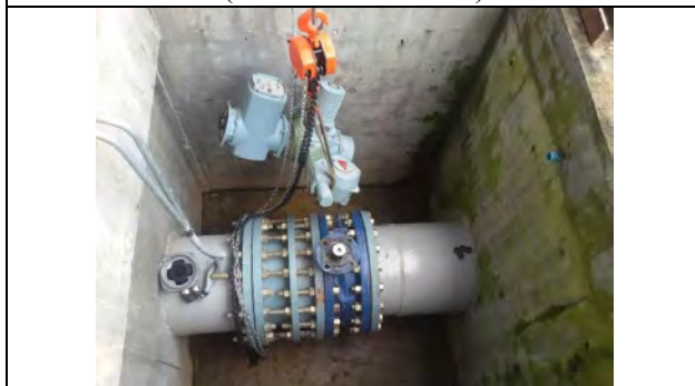
ろ過池の流入弁の修理 (2017年7月28日)
