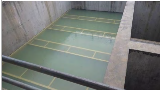
ろ過池の水張試験 (2016年10月28日)
