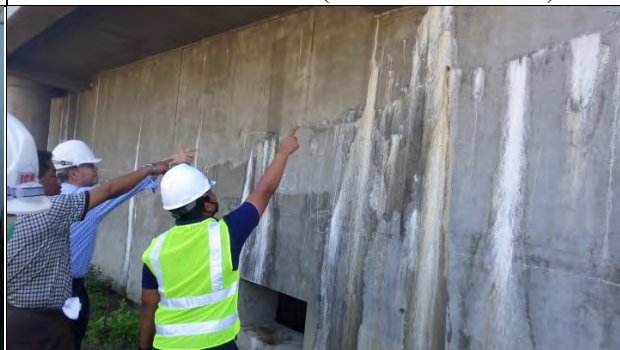
試験施工 (2017年1月14日)
