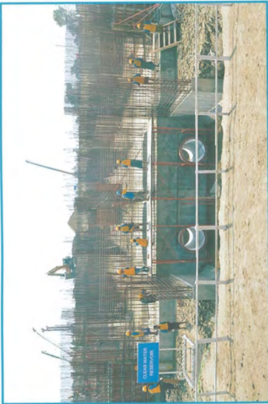
Clear Water Reservoir နေရာတွင် Tiebeam နှင့် Wall များအားတွန့်ကရစ်လောင်းနေပုံ
