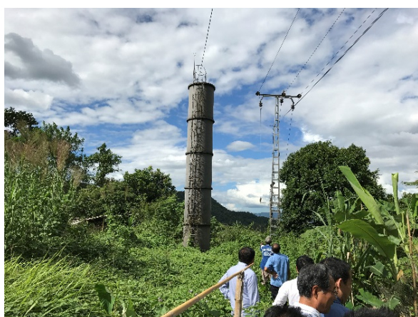
サージタンク調査
