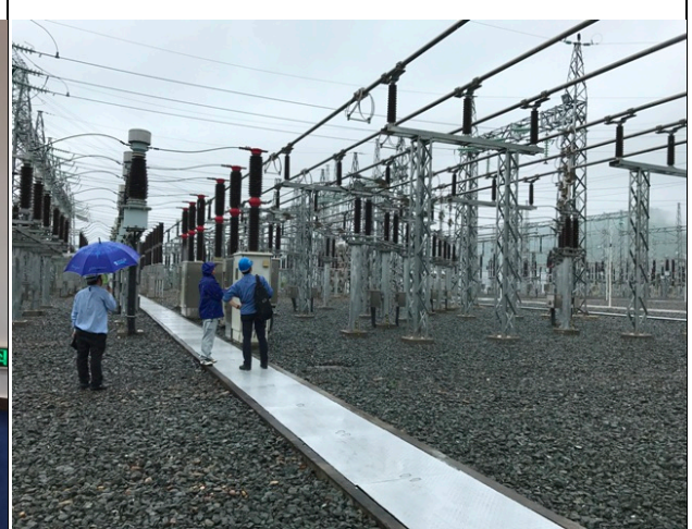
ルアンパバーン2変電所 通信線調査
