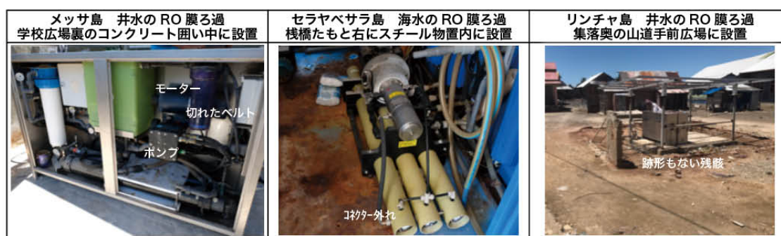
図1: メッサ島など周辺島嶼における故障し放置された小型RO膜ろ過装置
