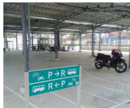
Công trình dân dụng tại vị trí sát cạnh Thư Viện tỉnh
