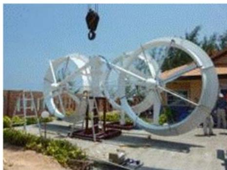
ディフューザー、ブレード間のギャップ測定
