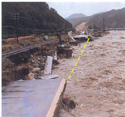
Foto Erosión del banco (Río Sendai), 1979
