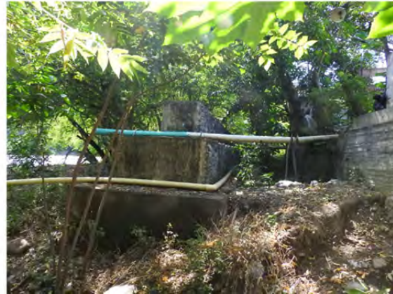
Gaviones + capa de concreto (locales)
