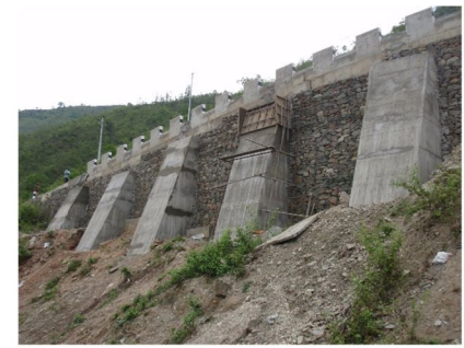
⑥ バットレスコンクリートによる 応急対策（DoR施工）
