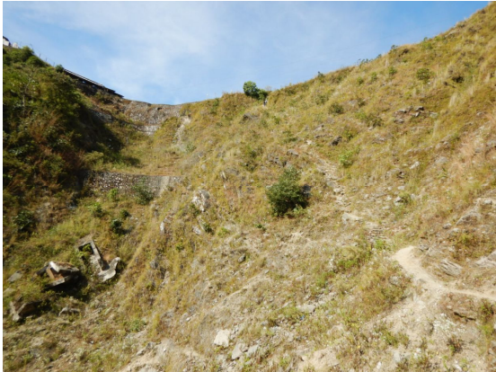
写真-3 Sta.17+400 の状況 斜面下方より撮影
