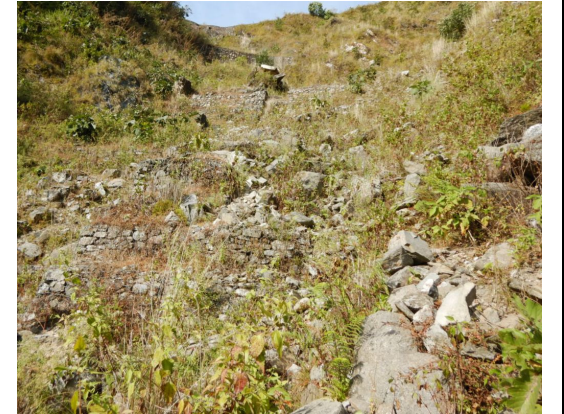
写真-4 Sta.17+400 の状況 斜面下方より撮影
