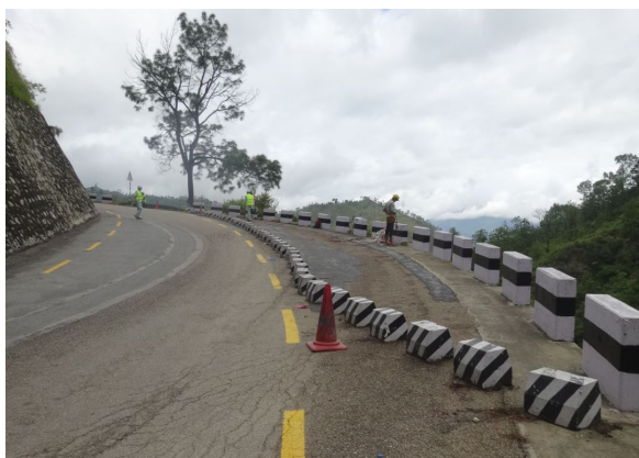
写真-7 Sta.33+695 の状況 現在1車線通行にて供用している。
