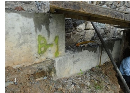
⑤ ガビオン擁壁の基礎に明瞭な変状は認められない。
