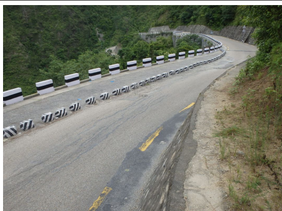
写真-5 Sta.33+440 の状況 現在1車線通行にて供用している。
