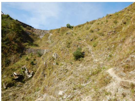
写真-3 Sta.17+400 の状況 斜面下方より撮影
