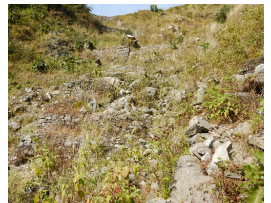
写真-4 Sta.17+400 の状況 斜面下方より撮影
