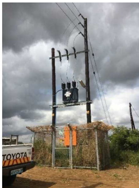
図 7.4-1 架空線用変圧器（100kVA）
