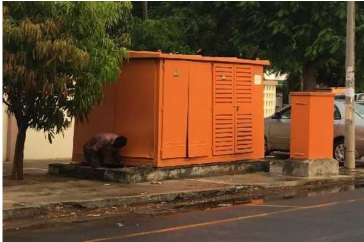
図 7.4-2 地中線用変圧器 (315kVA)
