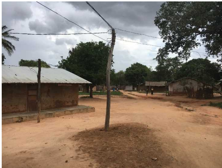
図 7.7-2 EDM 基準外接続配電線
