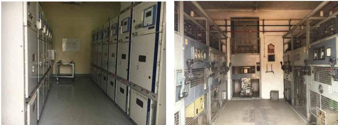
図 7.1-5 PS の内部（左：遠隔操作可能型、右：手動操作型）
